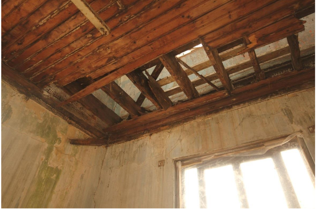
řekil 5. 26: 103 Numaralı Mekan Tavanının Gney Dođu Křesinin Mevcut Durumu (Erdim, 2019)
