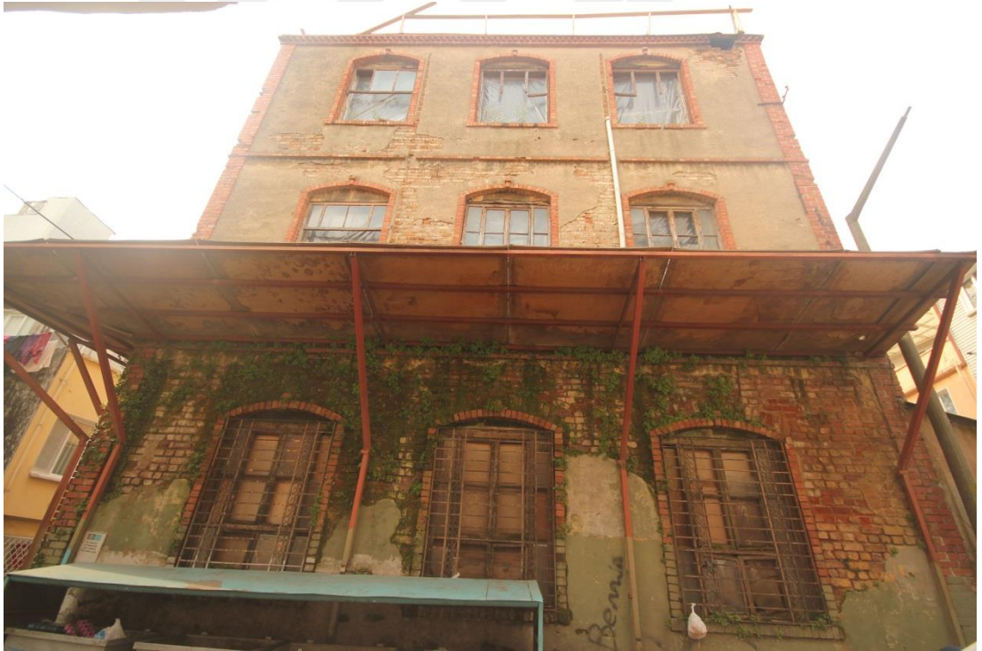
Şekil 5. 39: Sandalcı Mescit Sokak Üzerinden Kuzey Cephesinin Görünüşü (Erdim, 2019)
