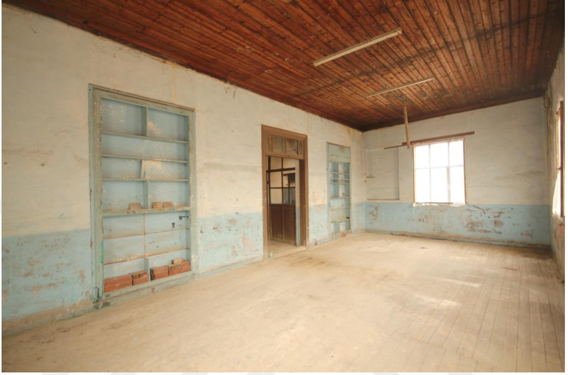
řekil 5. 32: 202 Numaralı Mekanın Genel Görünüřü, Gúney ve Batı Duvarına Bakıř ( Erdim, 2019)
