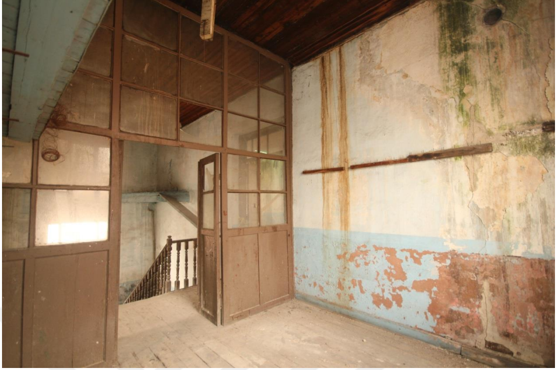
Şekil 5. 29: 202A Numaralı Mekanın Genel Görünüşü, Doğu Duvarına Bakış (Erdim,2019)
