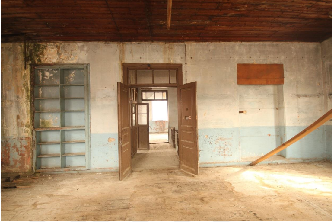
Şekil 5. 34: 203 Numaralı Mekanın Genel Görünüşü, Kuzey Duvarına Bakış ( Erdim, 2019)
