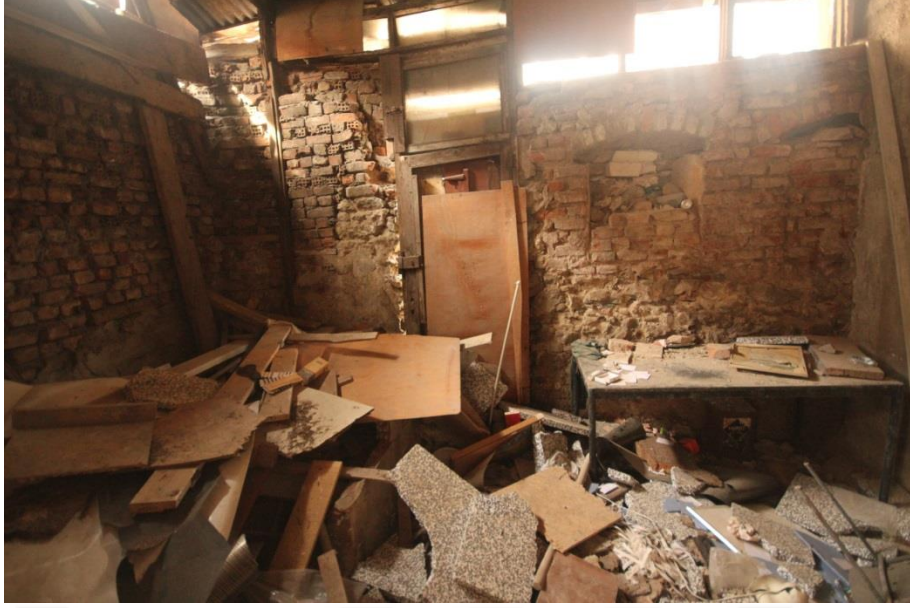
Şekil 5. 13: Z05 Numaralı Mekanın Genel Görünüşü, Batı Duvarına Bakış (Erdim, 2019)
