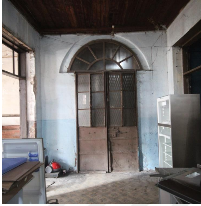
Şekil 5. 4: Özgün Ana Giriş Kapısının Z01 Numaralı Mekandan Görünüşü (Erdim, 2019)
