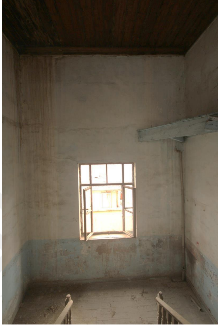
Şekil 5. 28: 201 Numaralı Mekandan Ana Merdiven Sahanlığına Genel Bakış (Erdim, 2019)
