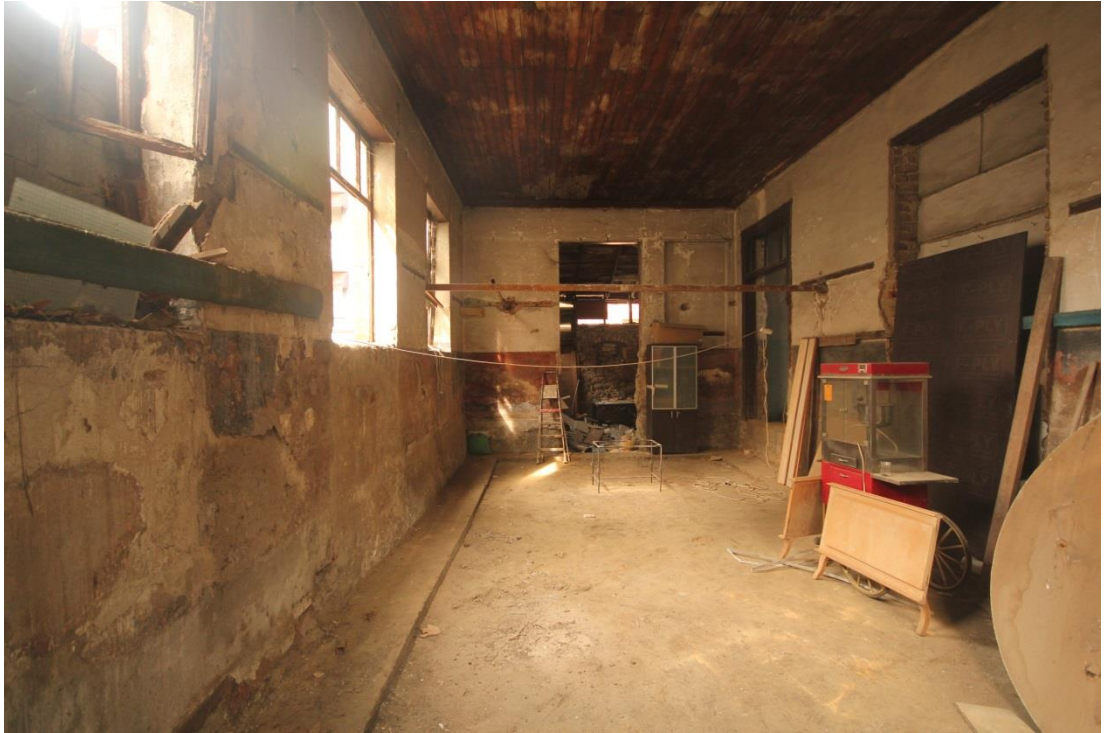
Şekil 5. 11: Z03 Numaralı Mekanın Genel Görünüşü, Batı Duvarına Bakış (Erdim, 2019)
