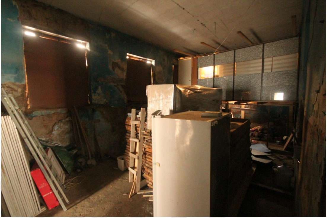
Şekil 5. 8: Z02 Numaralı Mekanın Genel Görünüşü, Kuzey ve Doğu Duvarları (Erdim, 2019)
