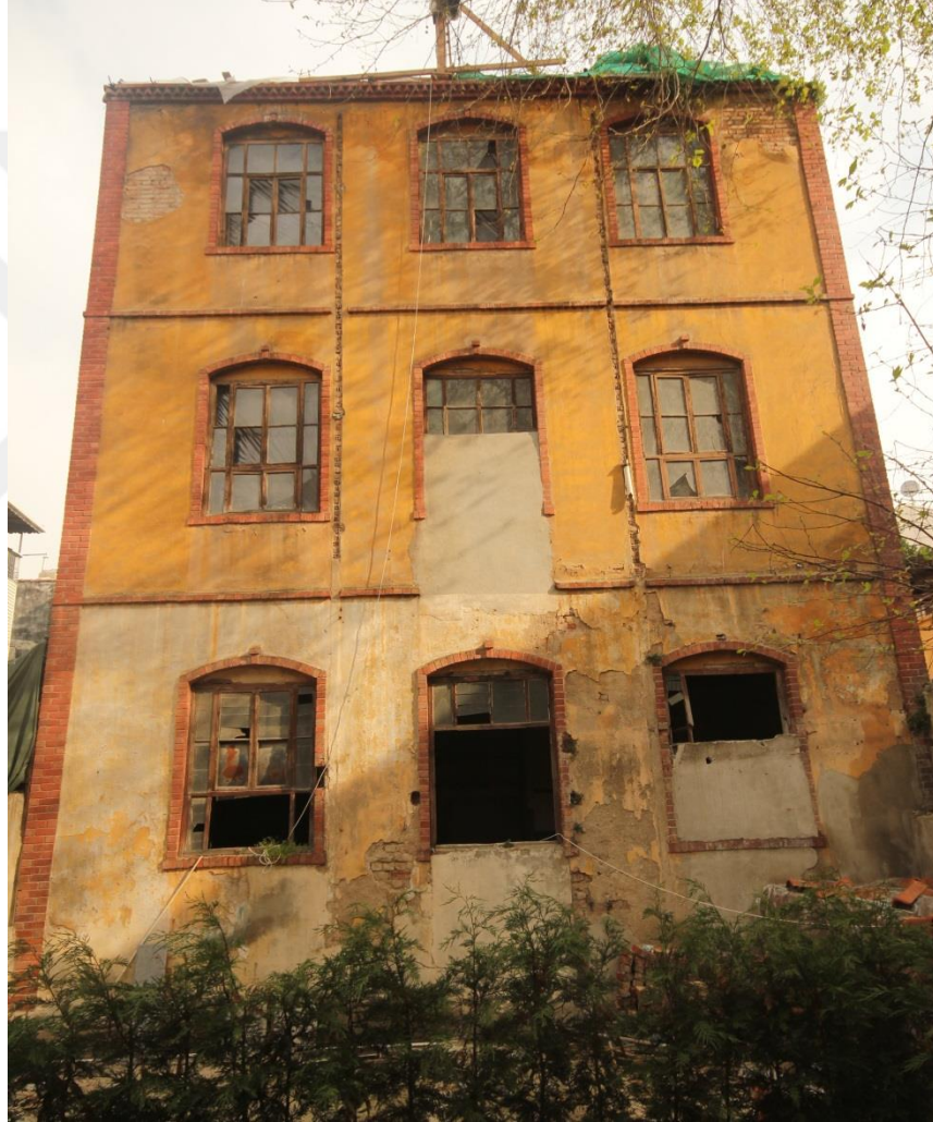
Şekil 5. 44: 2 Numaralı Parsel Tarafından Güney Cephenin Görünüşü (Erdim, 2019)
