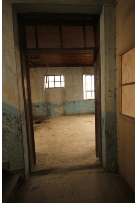
Şekil 5. 22: 101 Numaralı Mekandan 103 Numaralı Mekanın Özgün Kapı Girişinin Görünüşü (Erdim, 2019)
