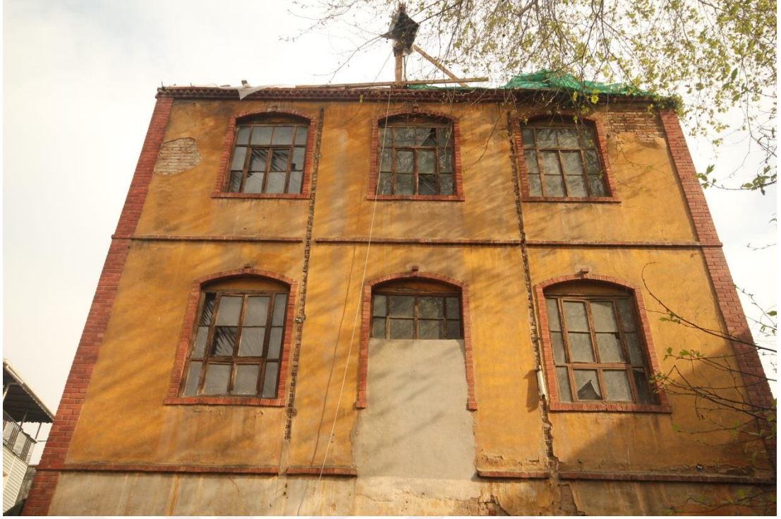
Şekil 5. 45: 2 Numaralı Parsel Tarafından Güney Cephenin Görünüşü (Erdim, 2019)
