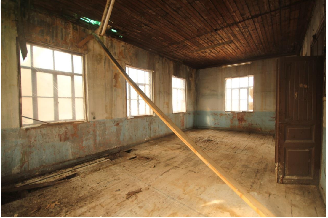
Şekil 5. 36: 203 Numaralı Mekanın Genel Görünüşü, Güney ve Batı Duvarına Bakış ( Erdim, 2019)
