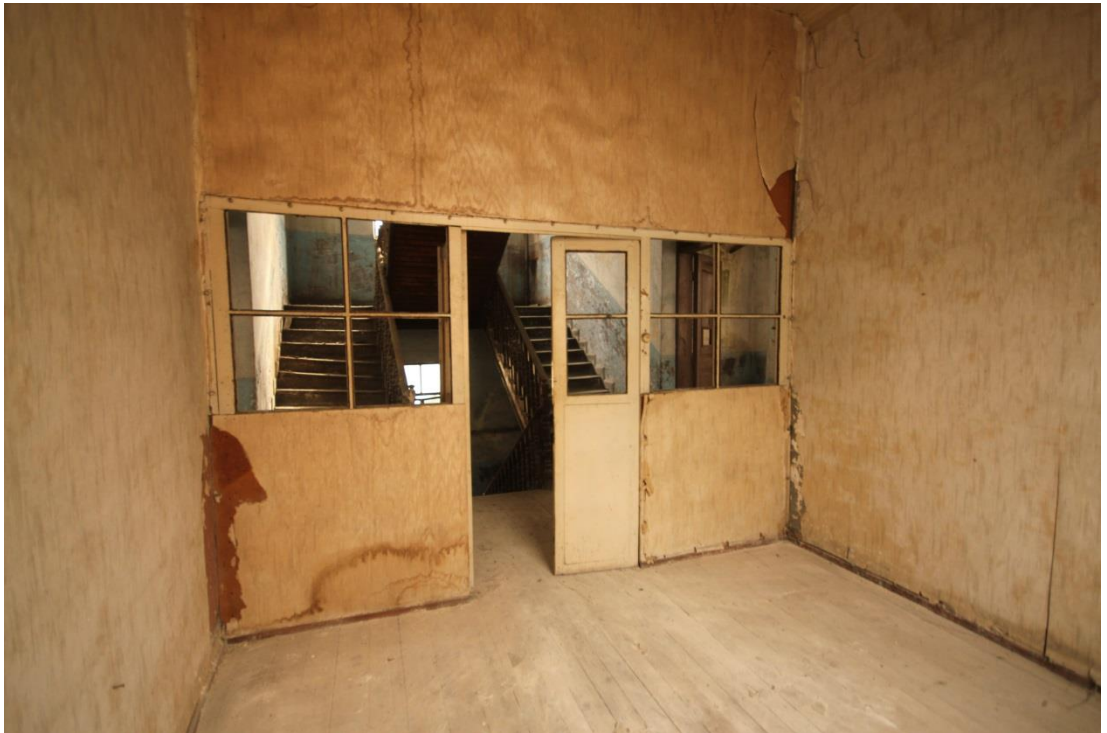
Şekil 5. 17: 101A Numaralı Mekanın Genel Görünüşü, Doğu Duvarına Bakış (Erdim,2019)
