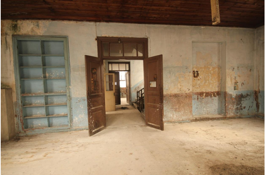
Şekil 5. 23: 103 Numaralı Mekanın Genel Görünüşü, Kuzey Duvarına Bakış ( Erdim, 2019)
