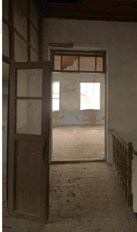
Şekil 5. 31: 201 Numaralı Mekandan 202 Numaralı Mekanın Özgün Kapı Girişinin Görünüşü (Erdim, 2019)
