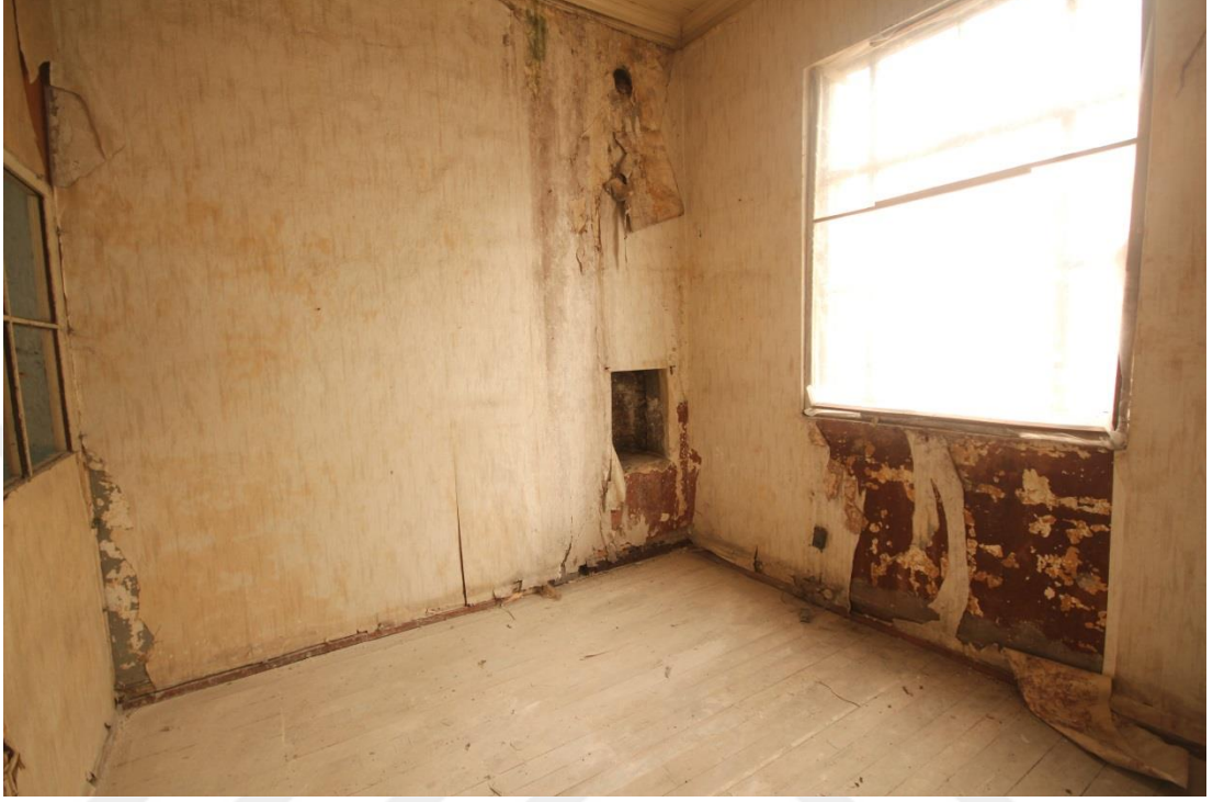
Şekil 5. 18: 101A Numaralı Mekanın Genel Görünüşü, Batı Duvarına Bakış (Erdim,2019)
