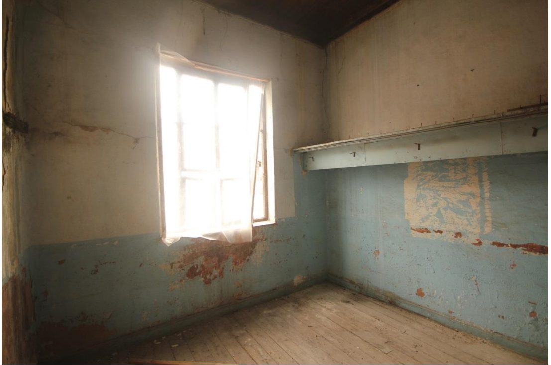
Şekil 5. 30: 202A Numaralı Mekanın Genel Görünüşü, Batı Duvarına Bakış (Erdim,2019)
