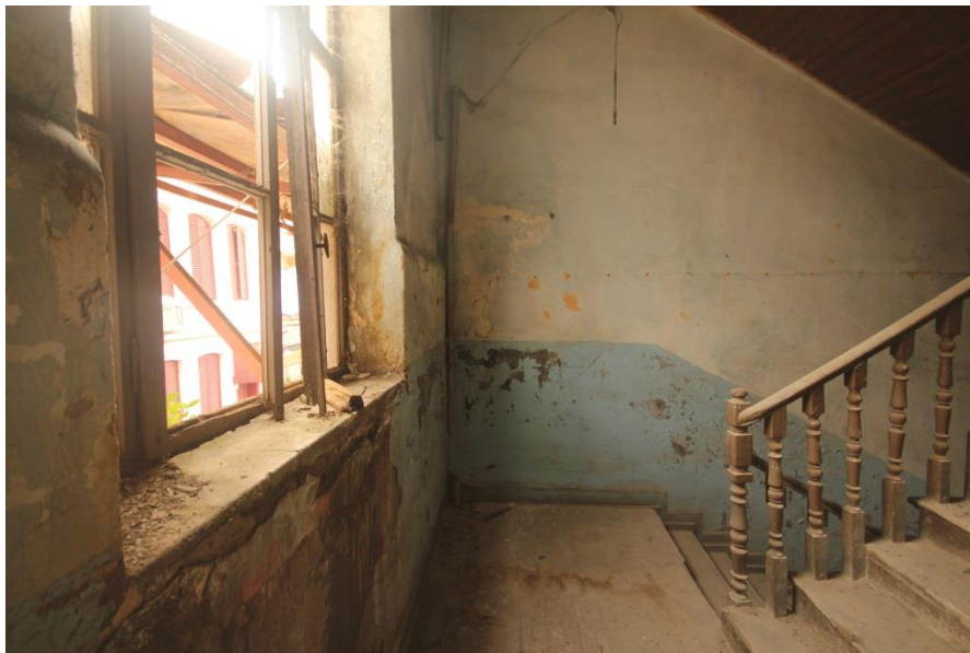
Şekil 5. 14: +2.07 Zemin Kotundaki Sahanlıktan Genel Görünüş (Erdim, 2019)
