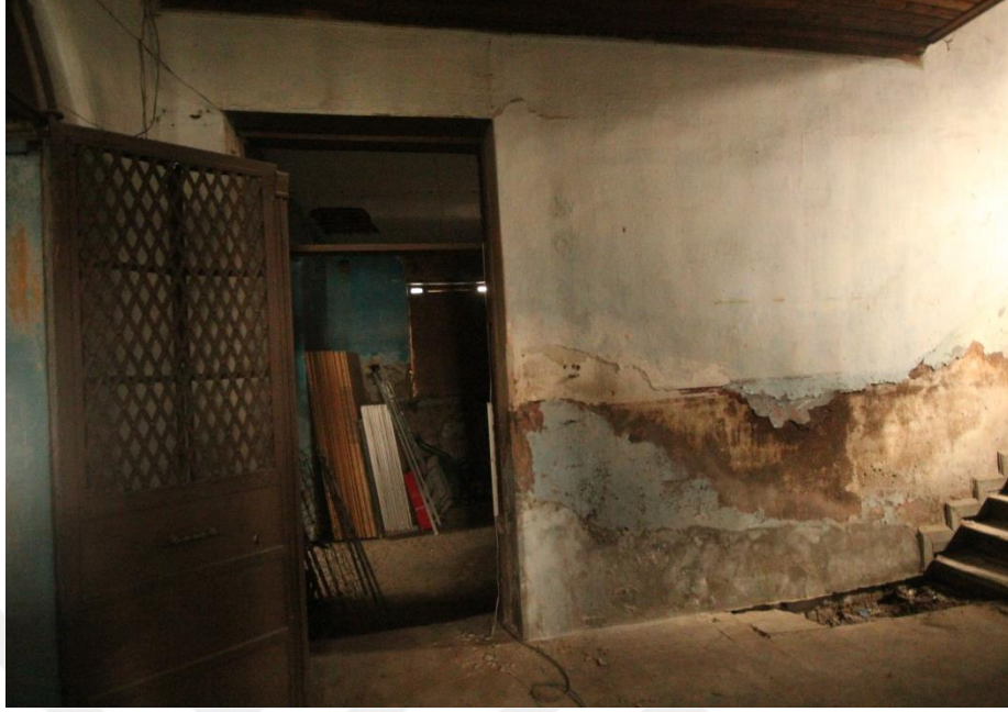
Şekil 5. 5: Z01 Numaralı Mekanın Doğu Duvarı (Erdim, 2019)
