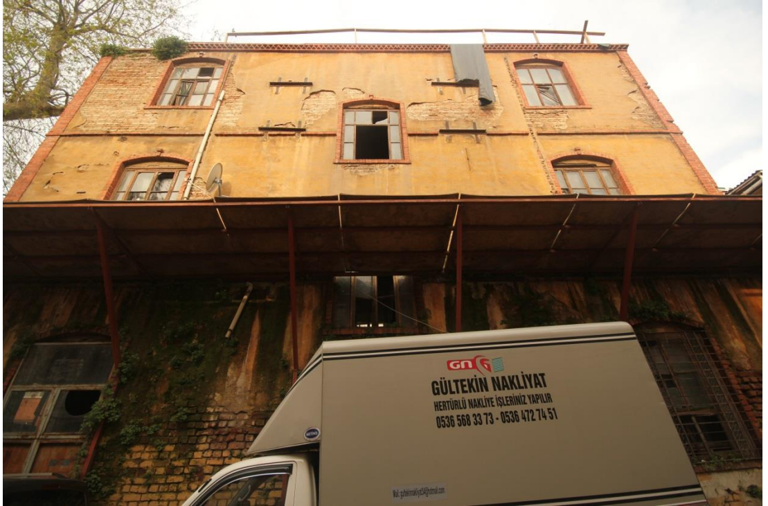
Őekil 5. 42: Byk Őekerci Sokak zerinden Dođu Cephesinin Grnř (Erdim, 2019)
