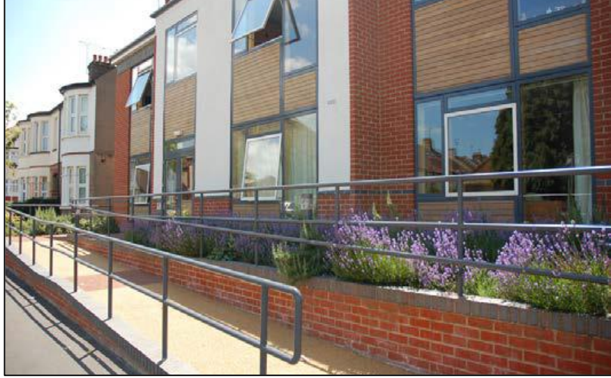
Şekil 4.17. Bina ile uyumlu malzemelerden yapılmış rampa çözümü 25 .
