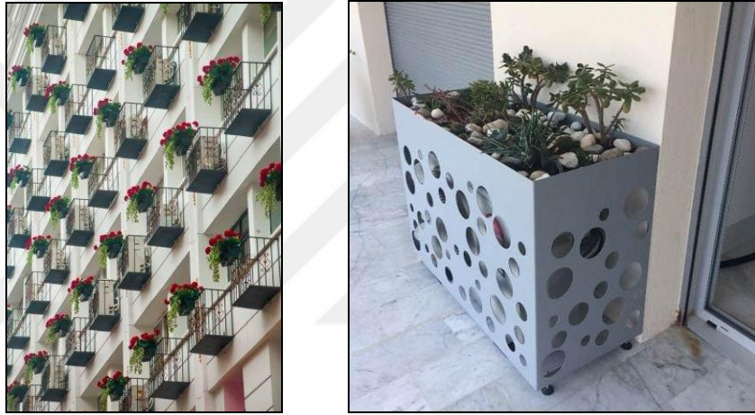
Şekil 5.36. Klima dış cephe ünitelerini gizleme yöntemleri 45 .
