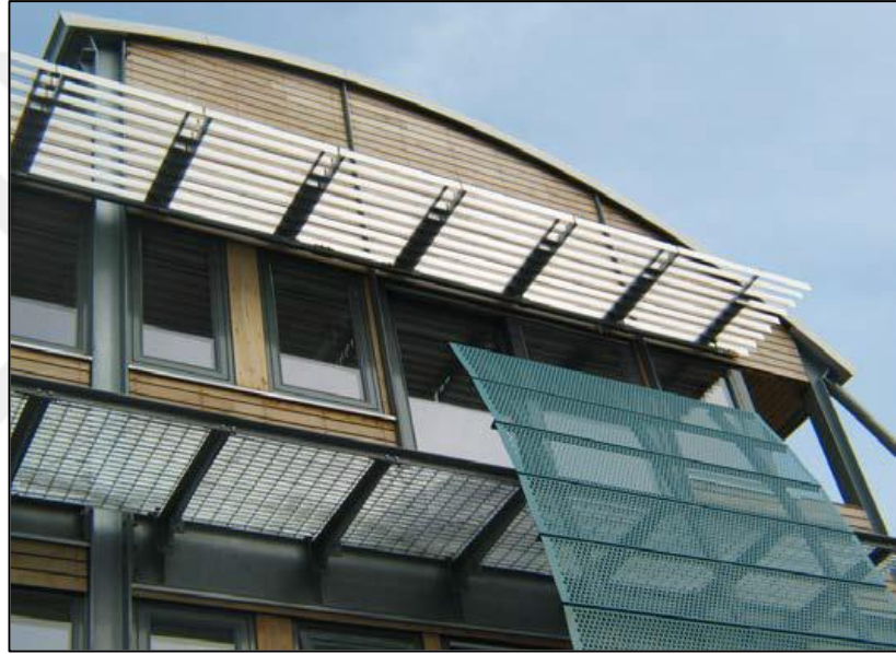
Şekil 4.16. Gölgeleme çözümleri için güneş kırıcılar 24 .
