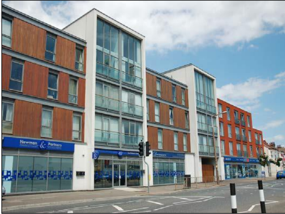
Şekil 4.15. Karma kullanım düzeninden dolayı oluşan yüksek yoğunluktaki konutlar 23 .
