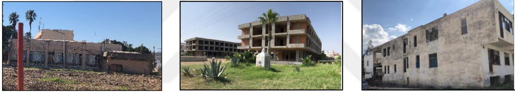
Şekil 5.25 Taşucu kıyısında bulunan terkedilmiş binalardan SEKA lojmanları, terkedilmiş otel inşaatı ve atıl haldeki bir bina (soldan sağa).
