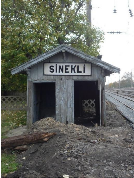
Şekil A.3. Sinekli istasyonu tuvalet yapısı (TCDD EMA, 2018)
