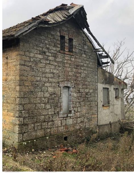
Şekil A.2. Kurfallı Lojman Binası yapıya eklenen ek bölüm
