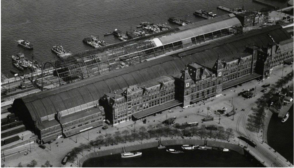
Şekil 13. Amsterdam Merkez İstasyonu (Url-9).
