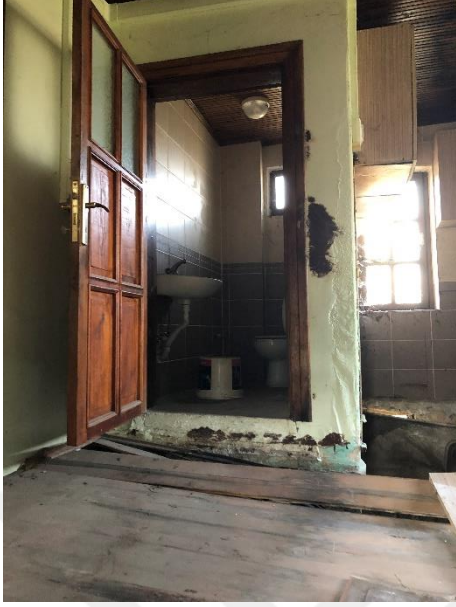
Şekil A.1. Velimeşe Lojman Binası ıslak hacim bölümü
