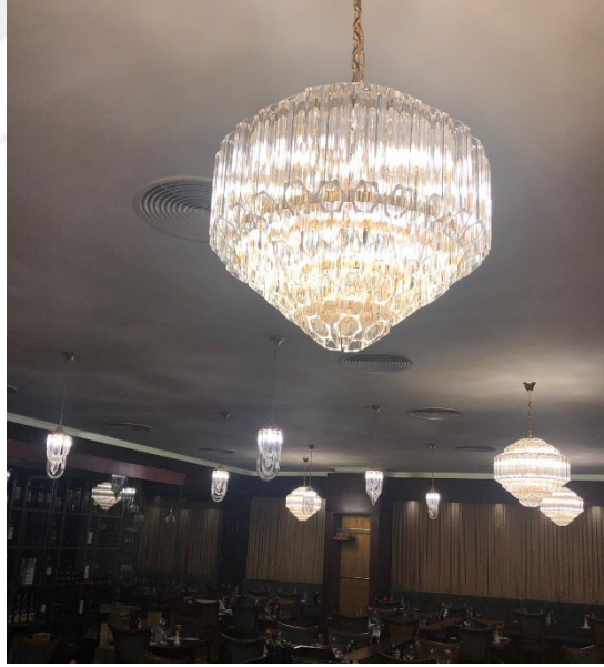
Şekil 122: Restoran yeme-içme alanında kullanılan aydınlatmalar
