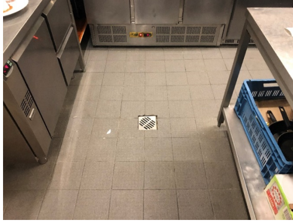
Şekil 104: Restoran mutfağının seramik zemini
