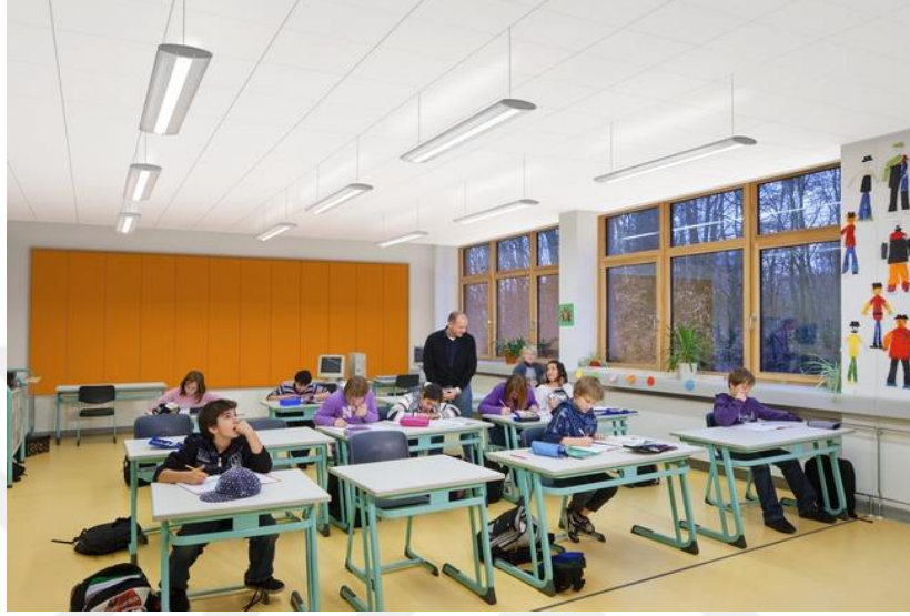
Şekil 3.23 : Yarı Gizli Taşıyıcılı Asma Tavan Örnek Fotoğrafı (30)
