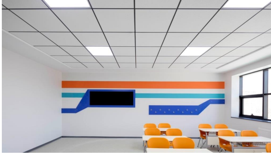
Şekil 3.10 : T15-T24 Görünür Taşıyıcı Sistem Örnek Fotoğrafı [30]
