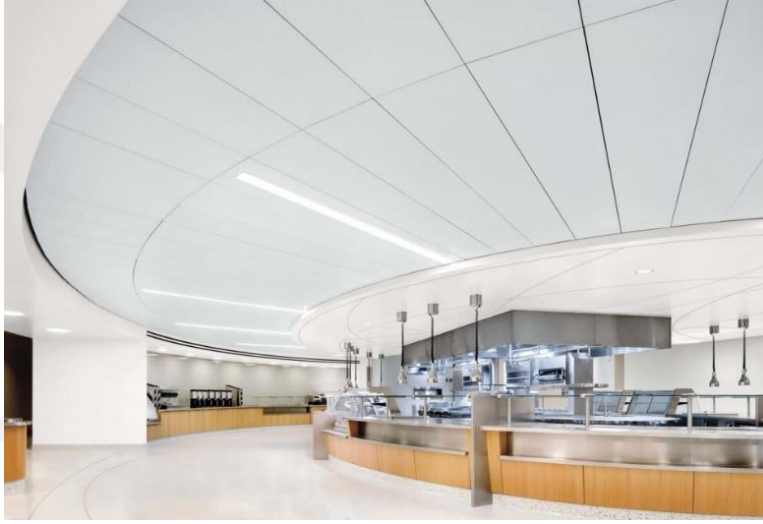
Şekil 3.17 : Gizli Taşıyıcılı Asma Tavan Sistem Örnek Fotoğrafı [30]
