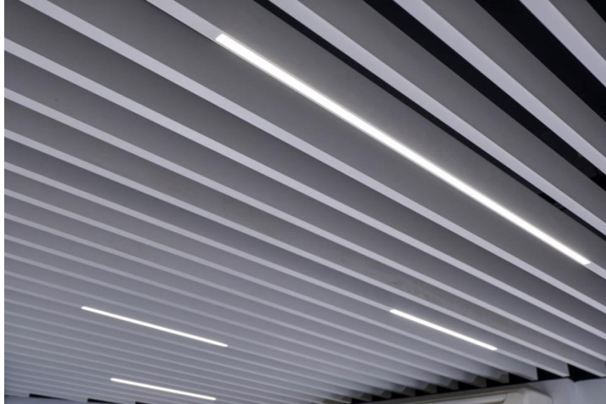
Şekil 3.40 : Lamel Metal Asma Tavan Uygulaması [30]
