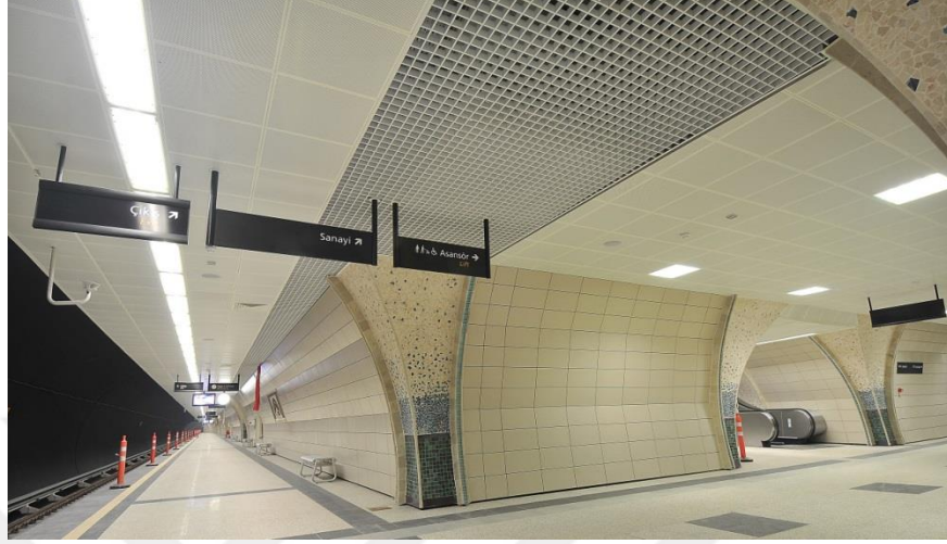
Şekil 3.39 : Izgara Metal Asma Tavan Uygulama Örneği [30]
