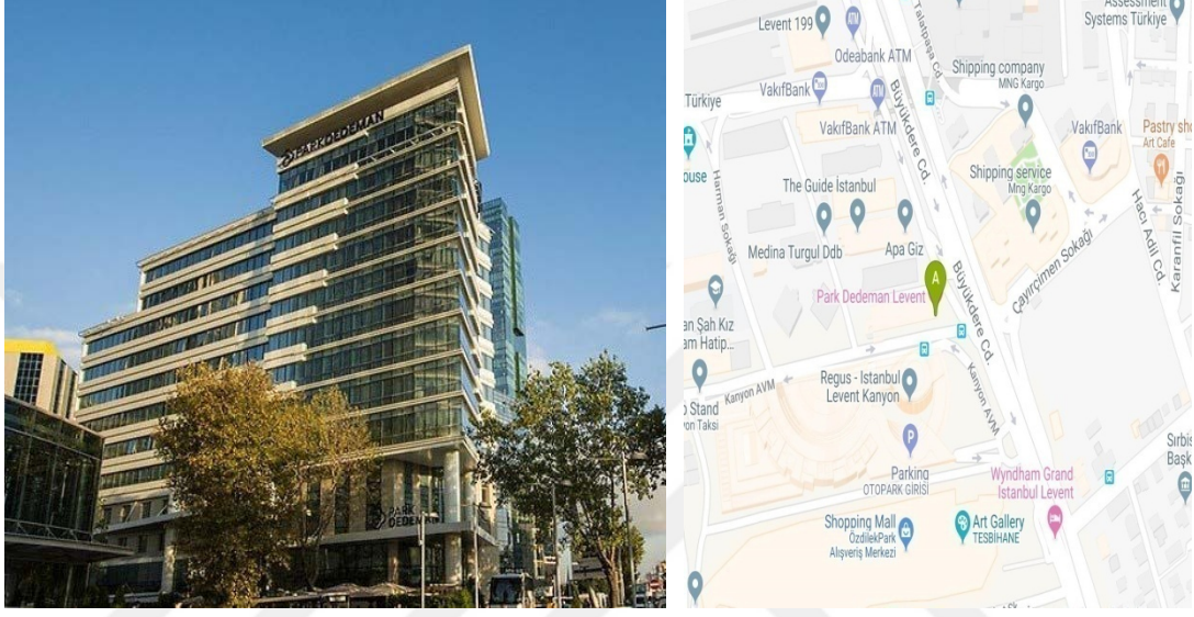
Şekil 5.11 : Park Dedeman Levent Otel Projesi [56,57]
