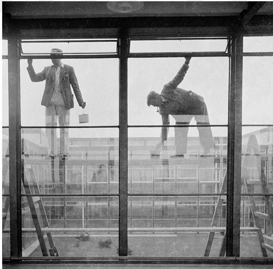
Şekil 2-13. Hunstanton Okulu inşaatı sırasında işçiler Fotoğraf: Nigel Henderson
