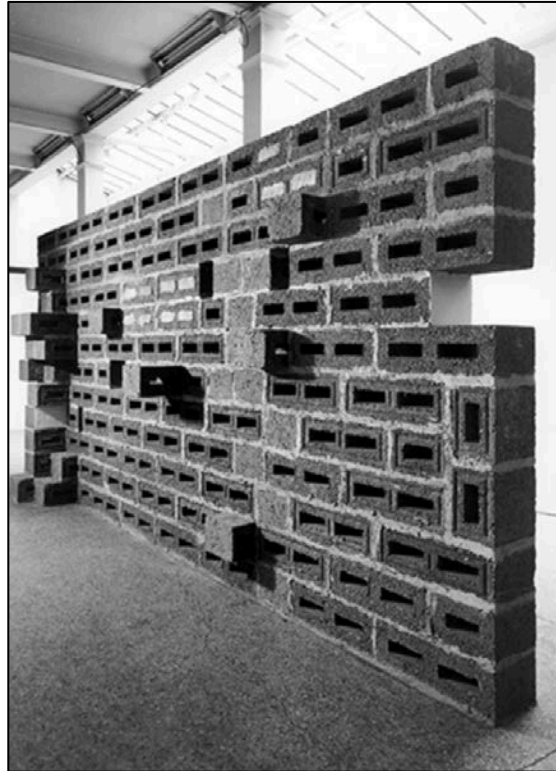
Şekil 3-49. Beton Blok Uygulanmış Hâli Grup 11 Fotoğraf: John Maltby / RIBA Collection
