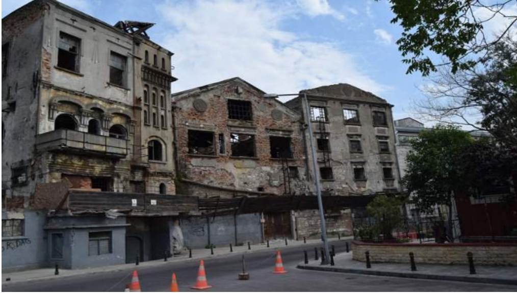
Şekil 6.23. : Tarihi Kasımpaşa Un Fabrikası yapılarının kuzey cephesi, 2017 (Url-44)
