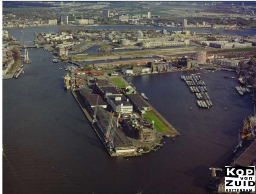
Şekil 5.30. : Kop Van Zuid bölgesinin Kentsel Yenilemeden önceki durumu (Url-22)
