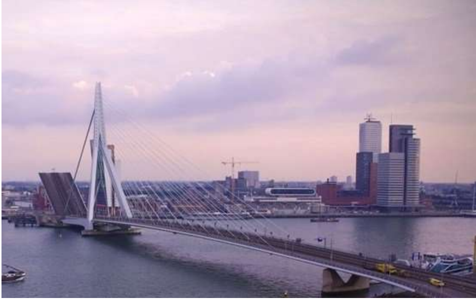
Şekil 5.34. : 1996 yılında yapımı tamamlanan Erasmus Köprüsü (Url-24)
