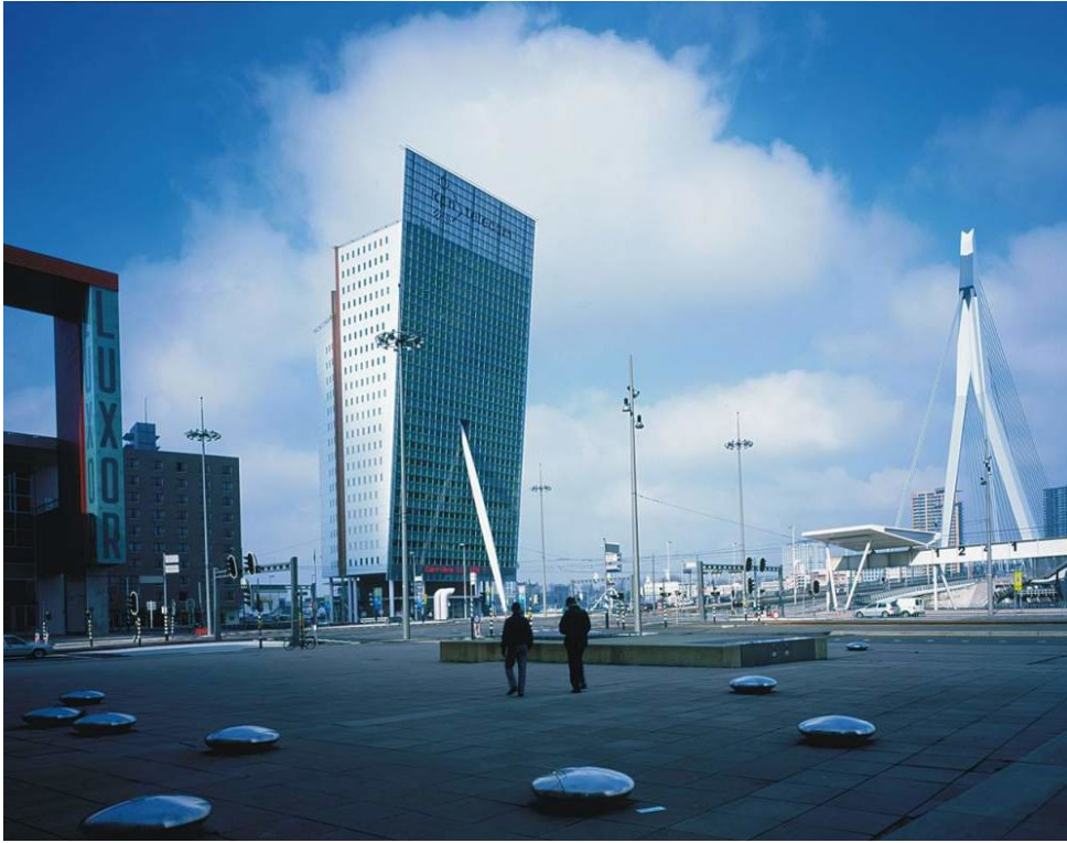
Şekil 5.36. : KPN Telekom Genel Müdürlük binası (Url-26)
