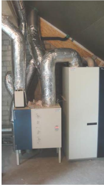
Şekil 1.18: Kombine ısıtma, havalandırma ve sıcak su sistemi[14].
