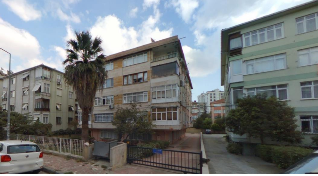
Şekil 3.4: Örnek Binanın fotoğrafı
