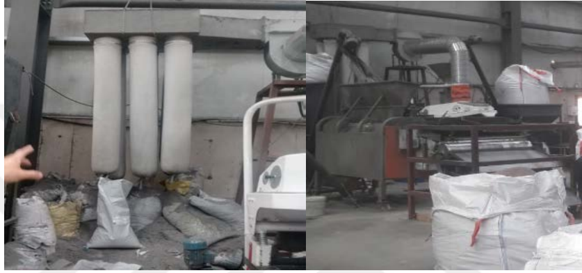
Şekil 2.31: Depolama silosu ve alanı
