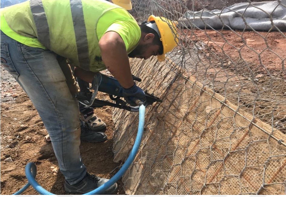
Şekil 4.8. Pnömatik tabanca ile halka birleştirme işlemi
