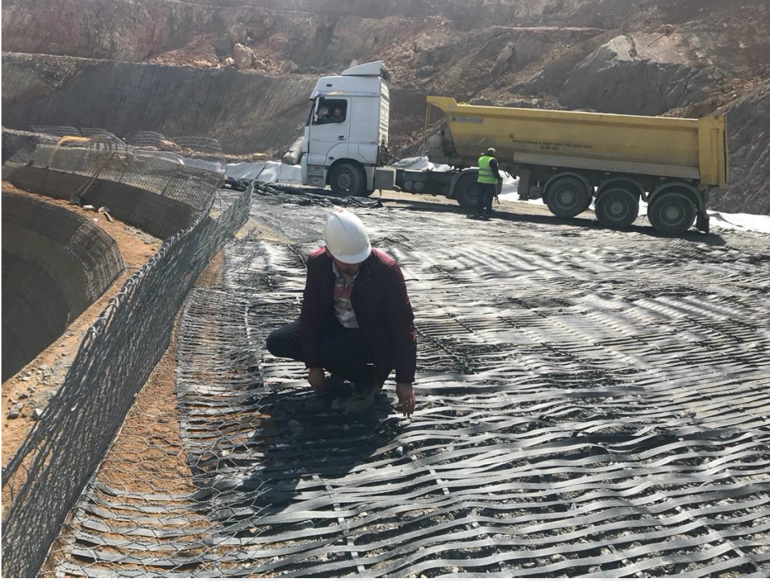
Şekil 4.11. Geogrid donatılarının yerleştirilmesi işlemi
