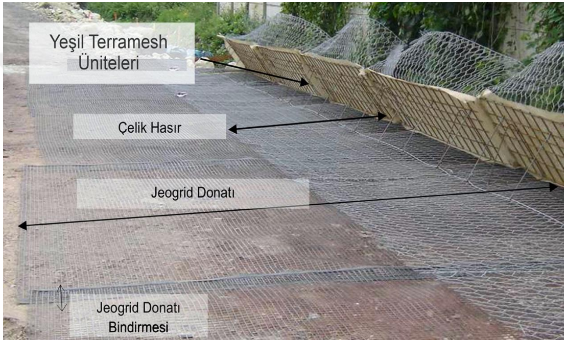
Şekil 4.5. Geogrid donatılarla güçlendirilmiş zemin katmanları
