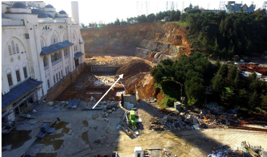
Şekil 2.6. Saha incelemesi ve verilerin toplanması
