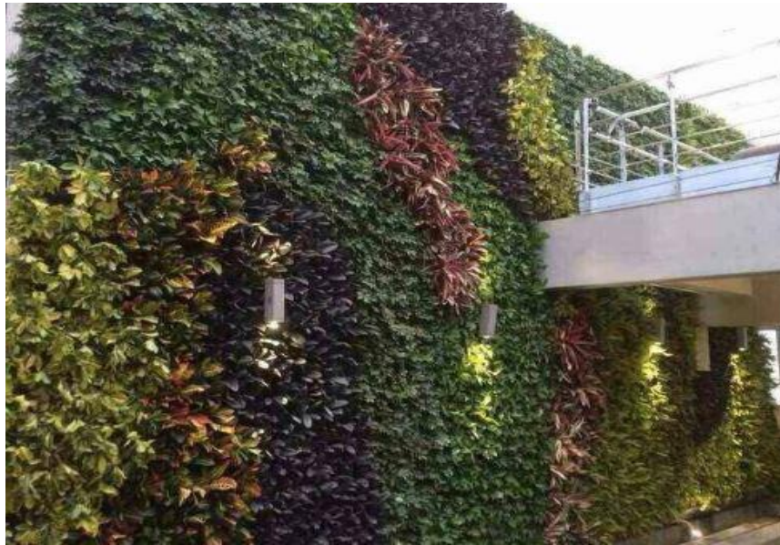
Şekil 6.11: Dikey Bahçe Sarmaşık Bitki Uygulaması
