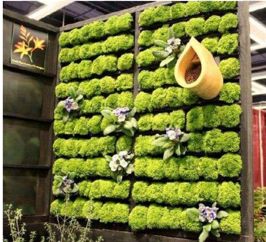
Şekil 6.2: Ahşap Taşıyıcı Profillerle Oluşturulmuş Dikey Bahçe
