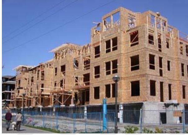
Şekil 2.14. Ahşap konstrüksiyon yapı üretimi (Kaynak: URL 9)
