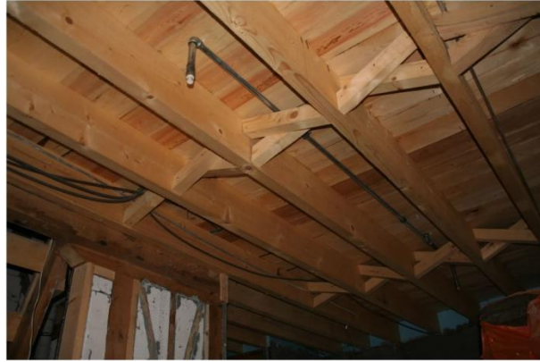
Şekil 2.15. Ahşap döşeme konstrüksiyonu (Kaynak: URL 9)
