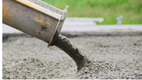
Şekil 2.16. Beton Döküm Aşaması (Kaynak: URL 11)
