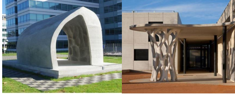
Resim 4.12: Fransa'da Vinci inşaat ve XtreeE tarafından üretilen üç boyutlu beton baskılı eserler (URL65)
