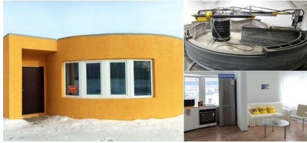
Resim 4.4: Apis Cor'un Rusya'da Moskova'da bulunan üç boyutlu baskılı yapısı (URL58)
