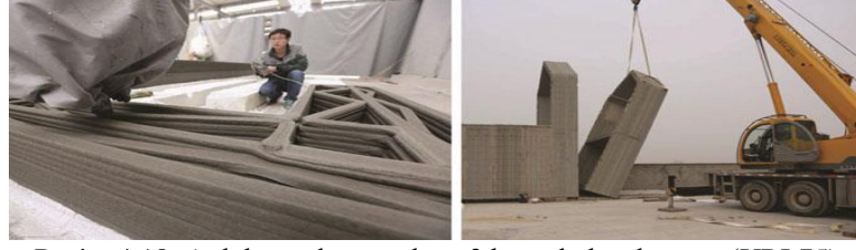
Resim 4.18: Atık betondan yapılmış 3 boyutlu basılmış ev (URL75)
