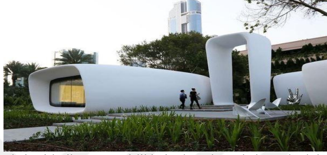
Resim 4.9: Dubai, Birleşik Arap Emirlikleri'nde üç boyutlu beton baskılı ofis (URL63)
