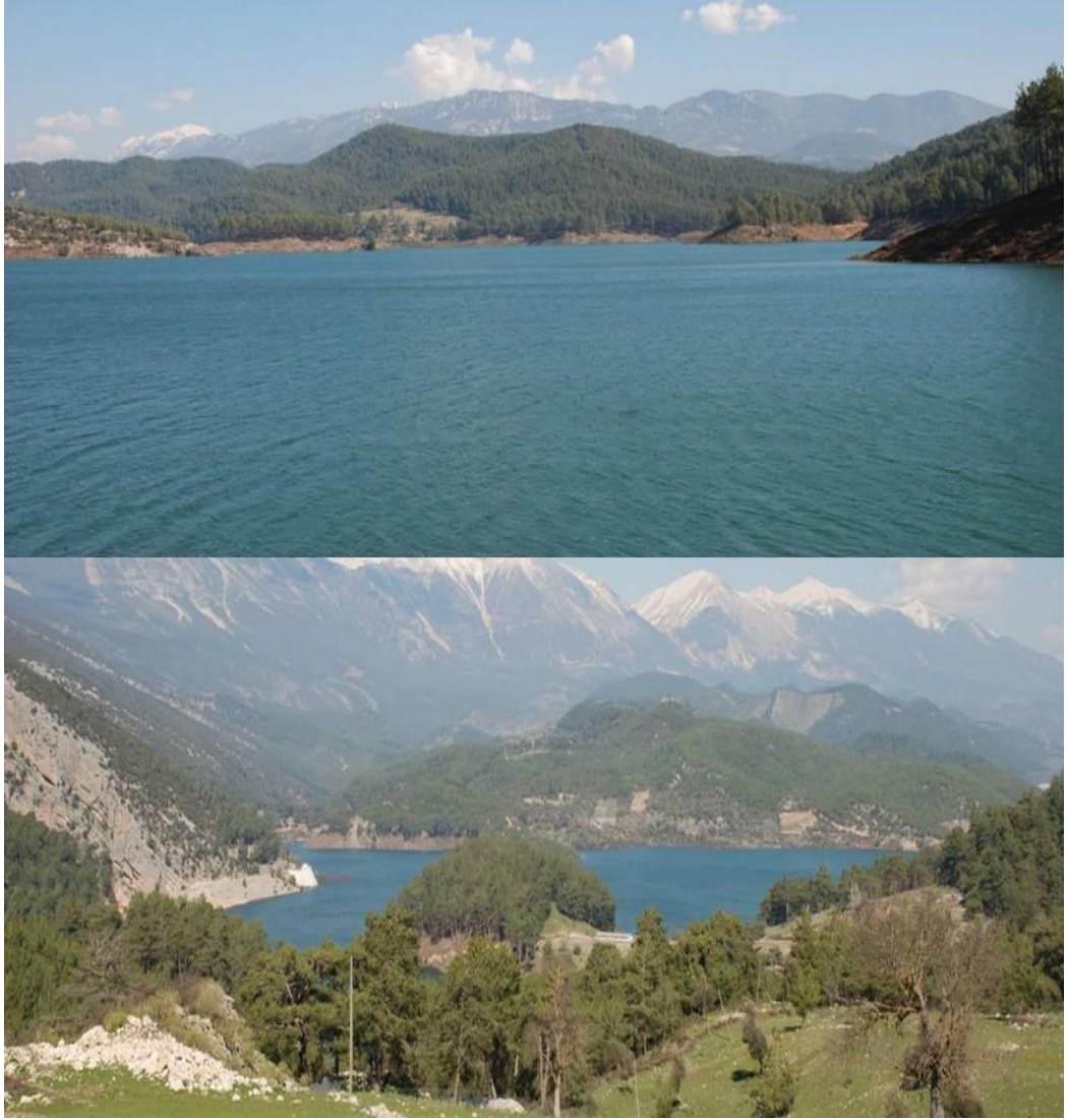
Fotoğraf 56: Alakır (Karacaören) Barajının farklı açılardan çekilmiş görüntüsü.
