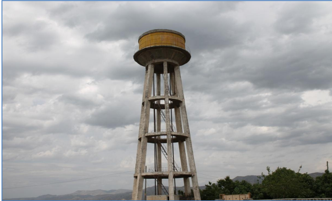
Foto 3: Cizre İlçesi Köy ve Mahalle Yerleşmelerinde Kurulmuş Olan Su Depoları
