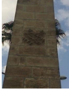
13: Güney Cephesi Üst Kitabe
