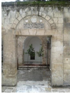
43: Hasan Paşa Camii girişi
