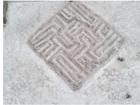
36: Dabakhane Camii batı kapısı İç içe geçmiş dört adet "Ali" yazısı
