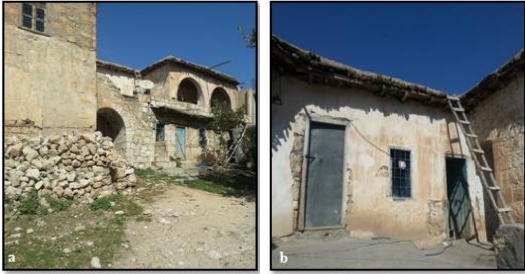
Foto 57. Kocahisar Köyü'ndeki Toprak, Düz Damlı Yapılar (a ve b)
