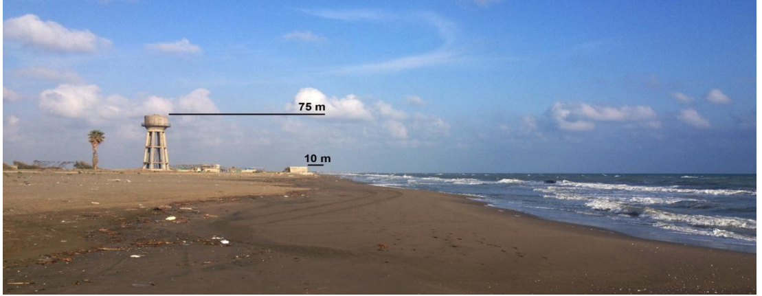
Şekil 2.18. Tuzla Lagünü kıyılarında inşa edilmiş su deposu ve bazı turistik tesislerin kıyı çizgisi gerilemesi sonucu kıyı çizgisine yakın bir konuma gelmeleri
