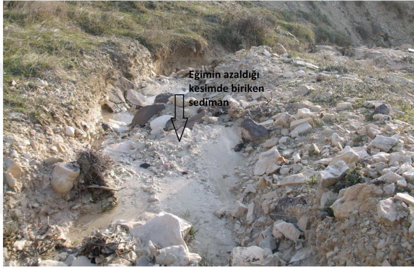
Şekil 5.18: Eğimin azaldığı kesimde blokların gerisinde oluşan lokal birikme alanlarından bir görünüm.
