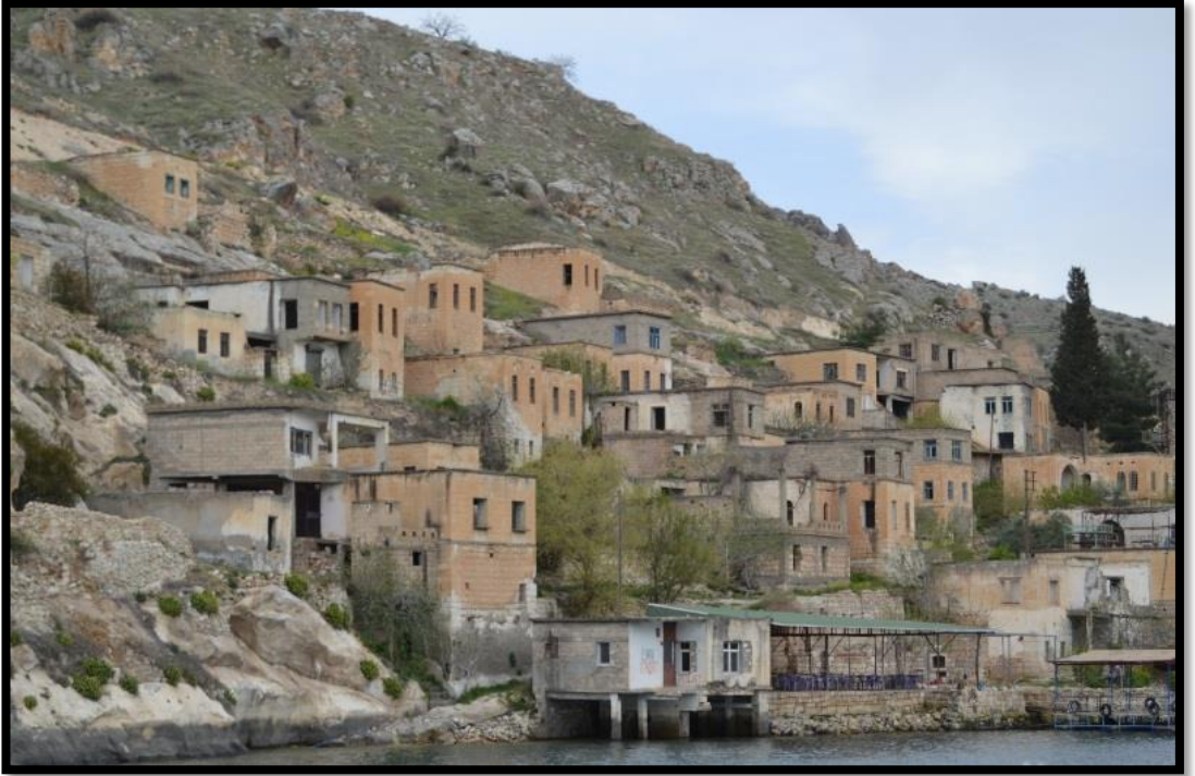
Resim 55: Eski Halfeti Yerleşmesinin 3 Km Kuzeyinde Sular Altında Kalan Savaşan Köyündeki Terk Edilmiş Evler
