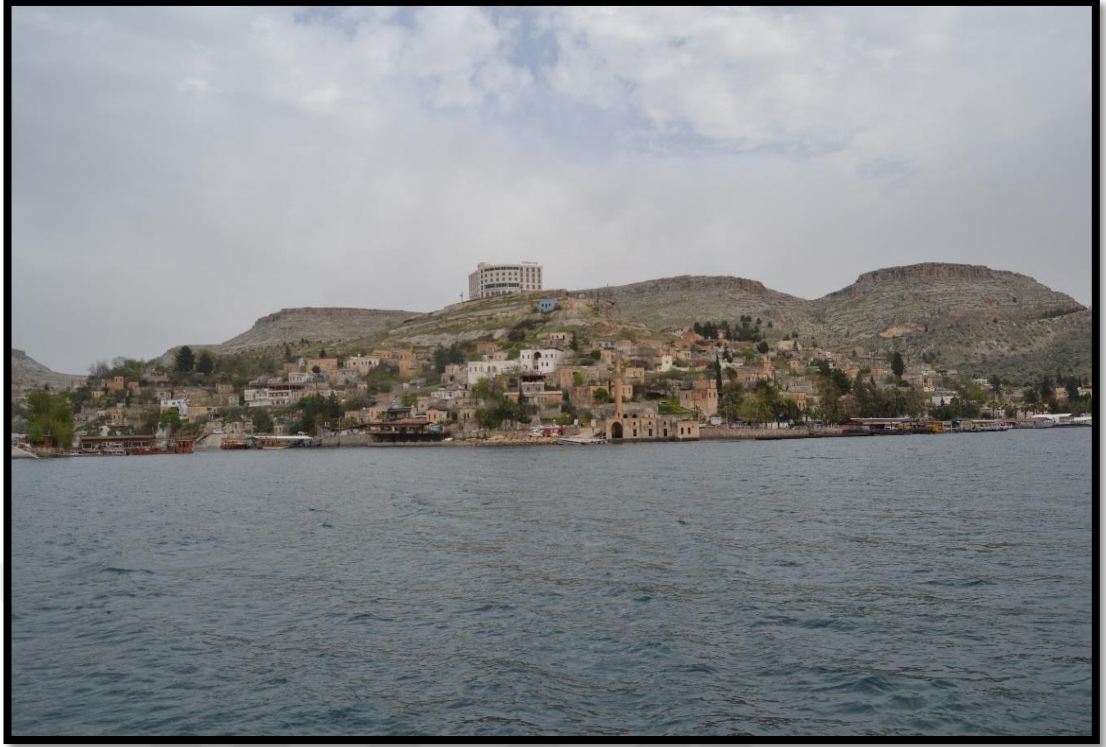
Resim 40: Eski Halfeti Yerleşmesinde Cittaslow Yönetmeliğine Aykırı Bir Yapı 1
