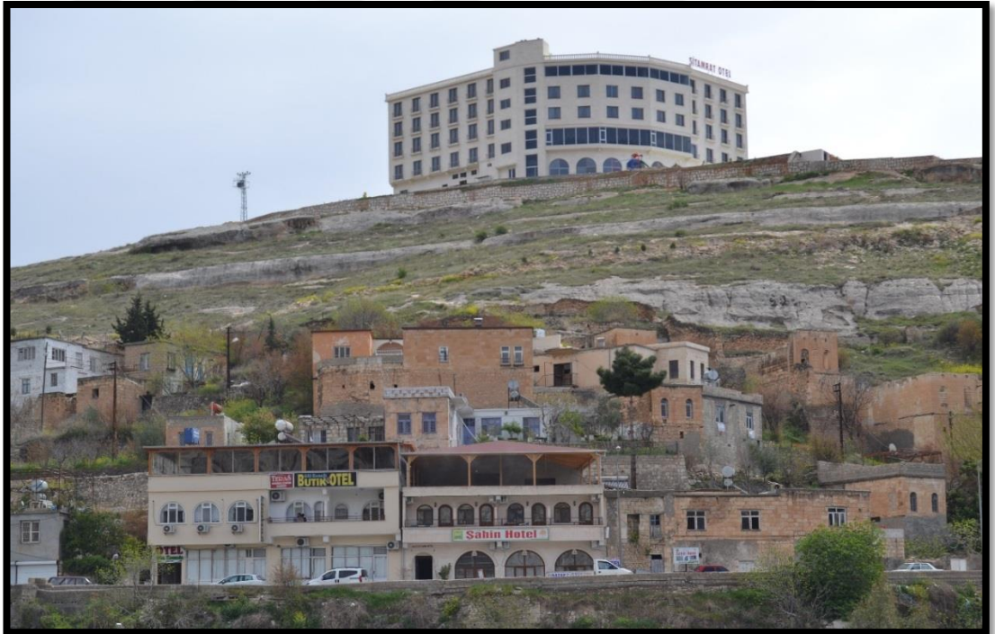
Resim 41: Eski Halfeti Yerleşmesinde Cittaslow Yönetmeliğine Aykırı Bir Yapı 2
