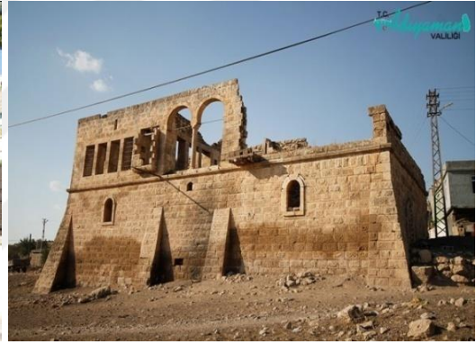
Foto 88: Vakkas Emiroğlu Konağı ( www.Adıyaman.gov.tr )
