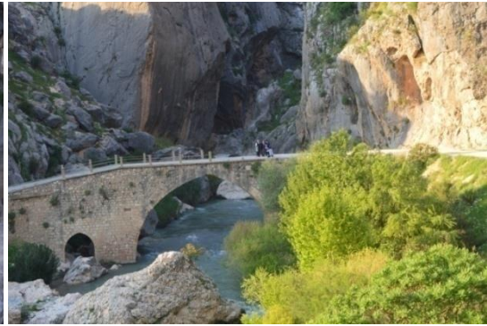
Foto 73: Selçuklu Aşağı Köprüsü
