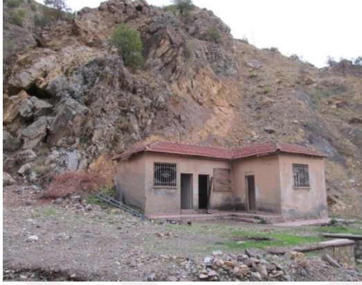
Foto 106: İmedeki Metruk Yapı
