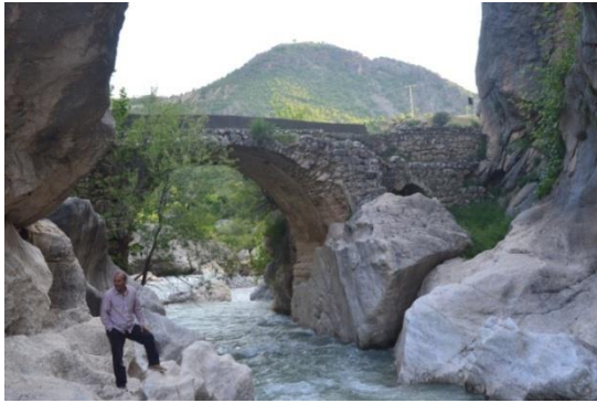
Foto 72: Selçuklu Yukarı Köprüsü
