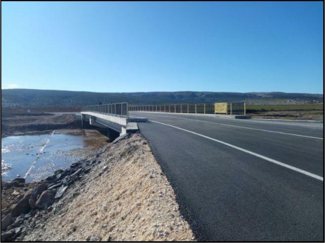
Fotoğraf 16: Karasu Çayı Üzerine Kurulan Karapınar Köprüsü
