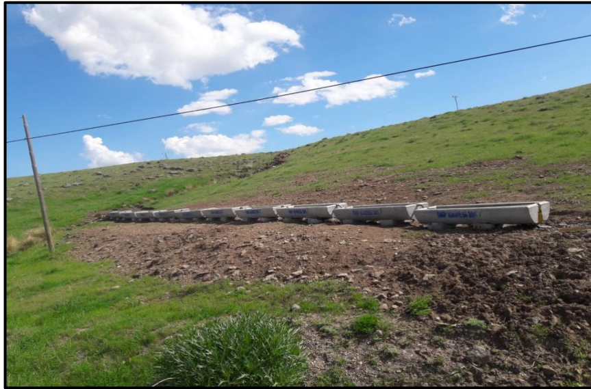
Fotoğraf 13: Van Büyükşehir Belediyesi'nin Kurmuş Olduğu Beton Sıvatlar
