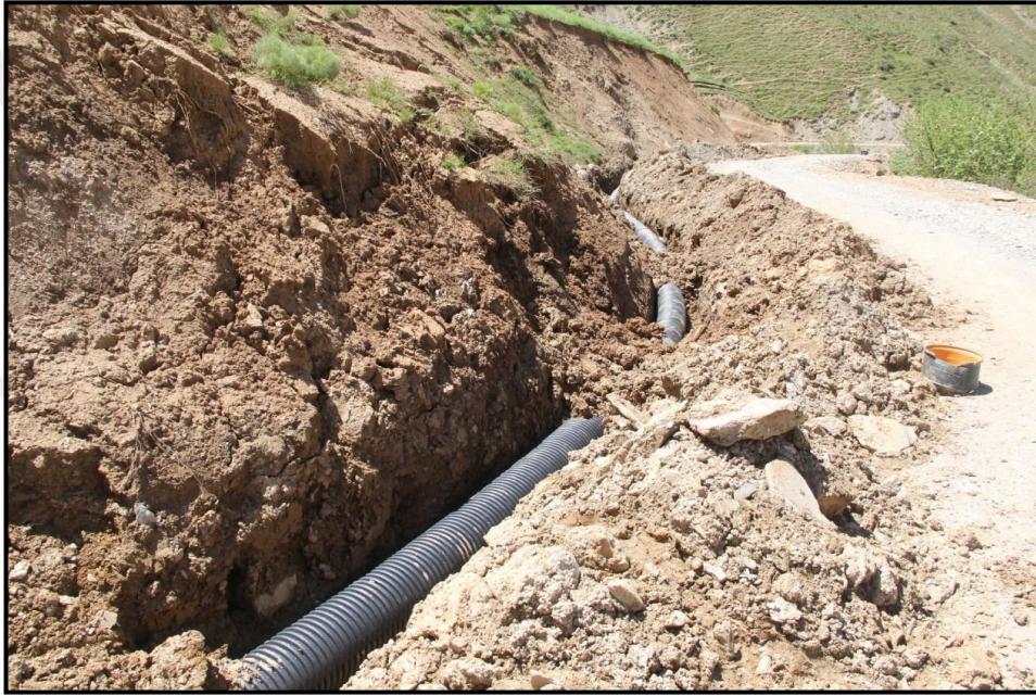
Fotoğraf 3: Van Büyükşehir Belediyesi'nin Döşediği Koruge Borular
