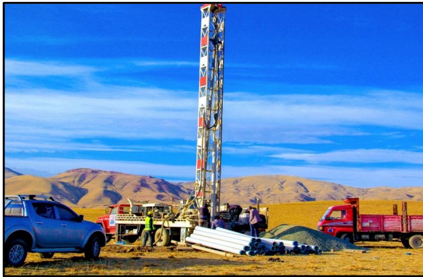
Fotoğraf 14: Hayvansal Sulama İçin Açtığı Sondaj Kuyularından Biri
