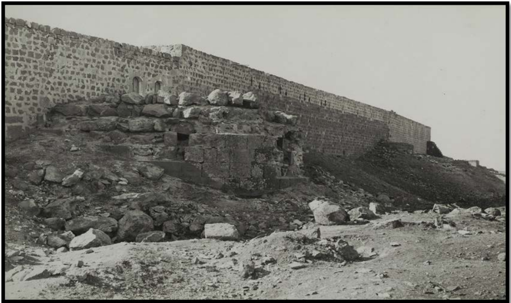
Şekil 57: Viranşehir Tarihi Surlarından Bir Görünüm.
