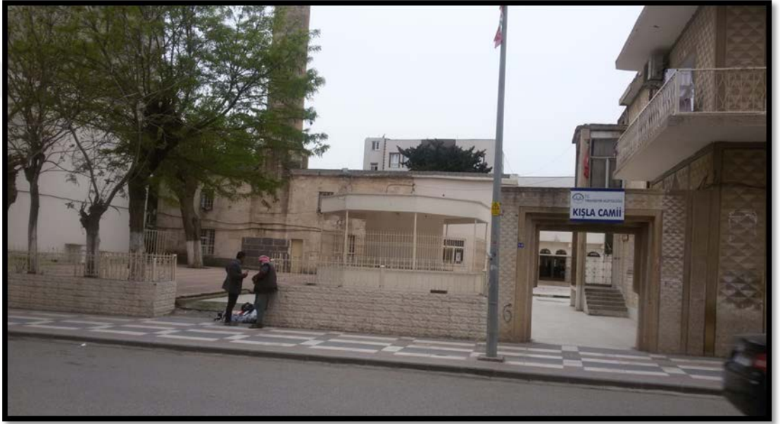
Şekil 58: Viranşehir Ulu (Kışla) Camisinden Bir Görünüm,2018.
