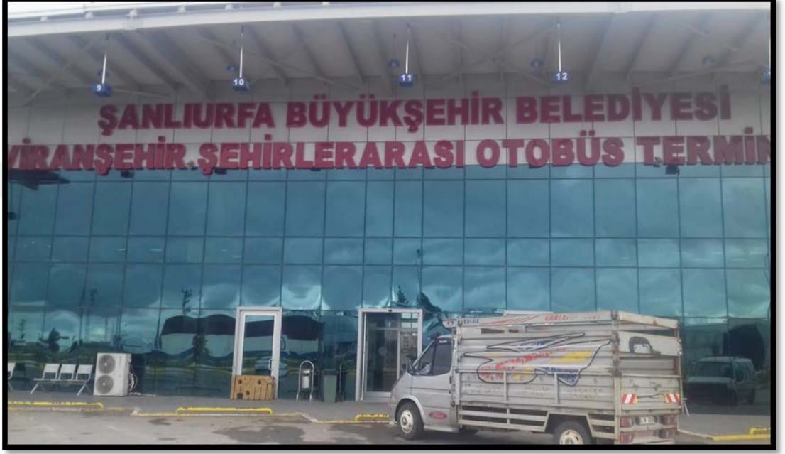
Şekil 53: Viranşehir Şehirler Arası Otobüs Terminali, 2018.
