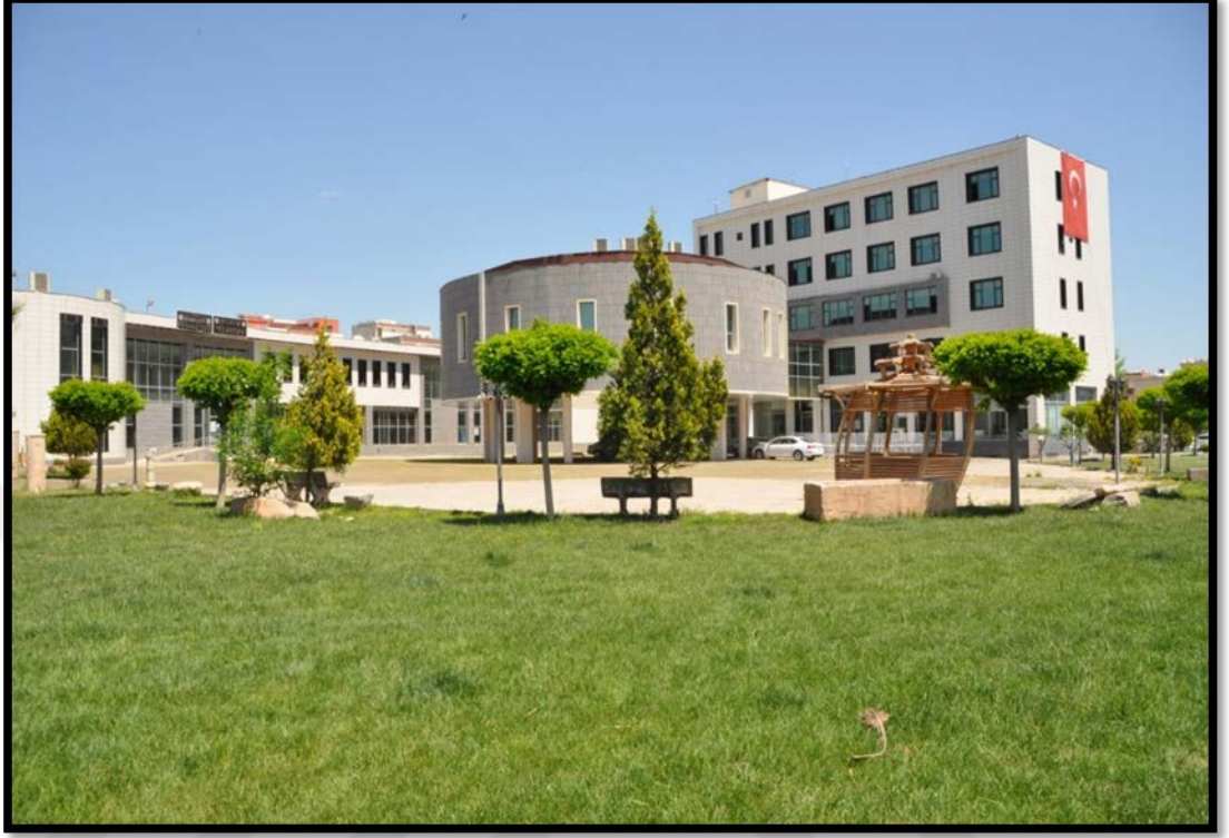
Şekil 17: Viranşehir Belediye Hizmet Binasından Bir Görünüm.
