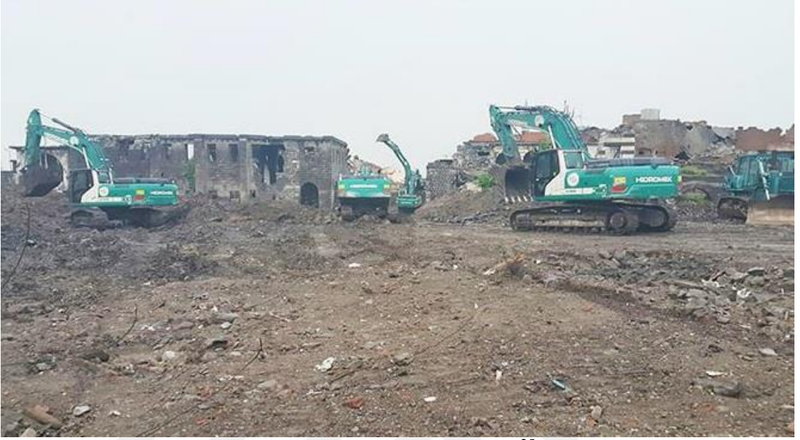
Fotoğraf 9: Suriçi’nde Yıkılmış/Zarar Görmüş Tescilli Yapılar
