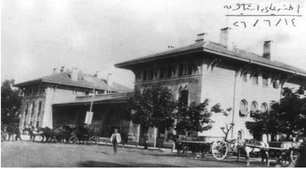
Ek- 19: Adana İstasyonu 432
