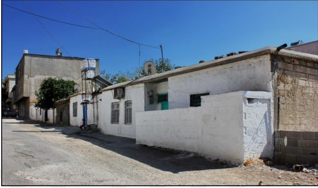
Foto 10: Kâhta Şhrinde Daimi Olarak İkamet Edilen Tek Katlı Ve Holliklere Benzer Niteliğe Sahip Meskenlerden Bir Görünüm
