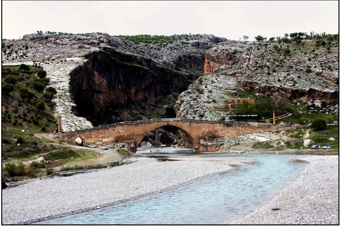
Foto 2: Cendere Çayının Güneyinden Bir Görünüm
