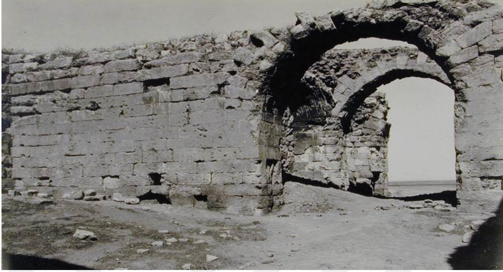
Şekil 5: Emevi Dönemine Ait Üçüncü Kattaki Saray Yapısı
