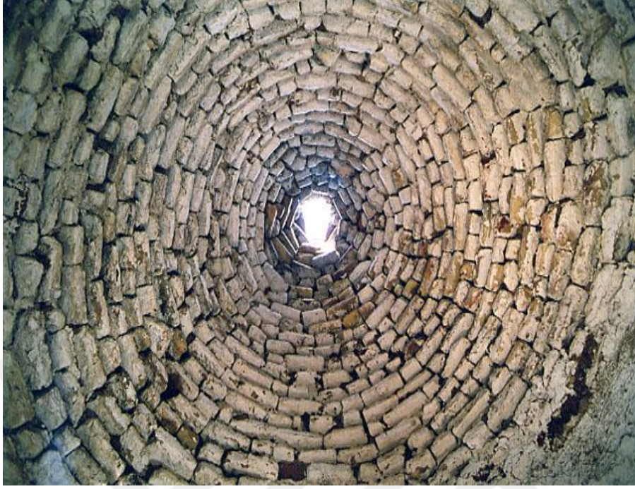
Şekil13: Konik Kubbeli Evlerin Bindirme Teknikli Kubbesi
