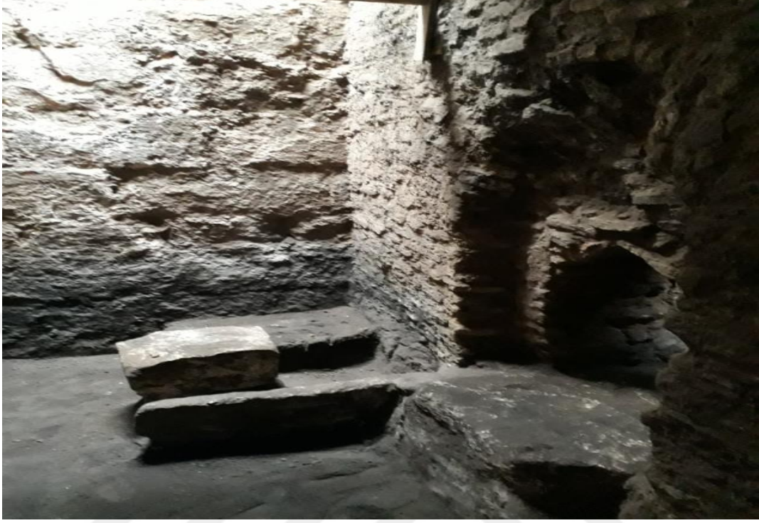
Doğu Cephede Üst Örtünün Oturduğu Masif Payeler ve Üçüncü Kata Çıkışı Sağlayan Rampa
