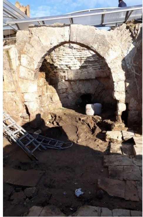
Hamam Sıcaklığını Oluşturan Sahınlar, Üst Örtüyü Taşıyan Kemer ve Payeler
