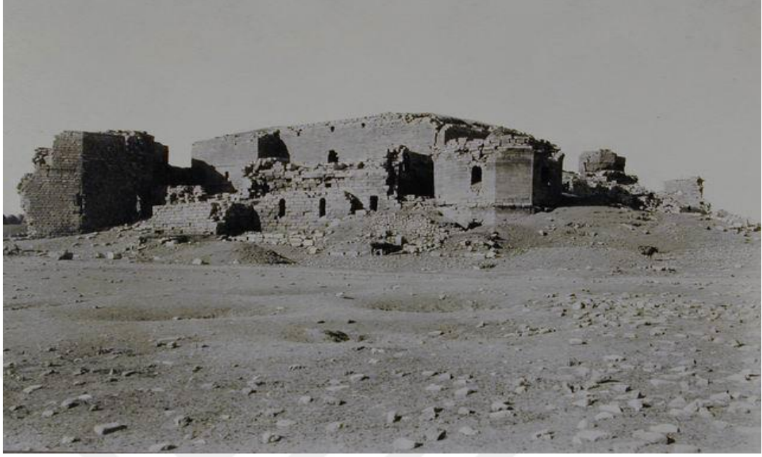
Şekil 2: Harran İçkale Güney Cephesi
