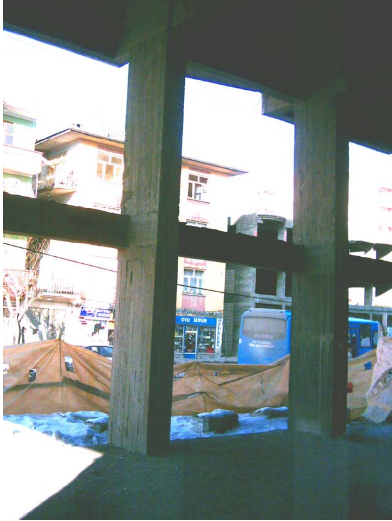
Şekil 4.14. Projesi ve hesaplamaları yapılan binanın zemin kat fotoğrafı
