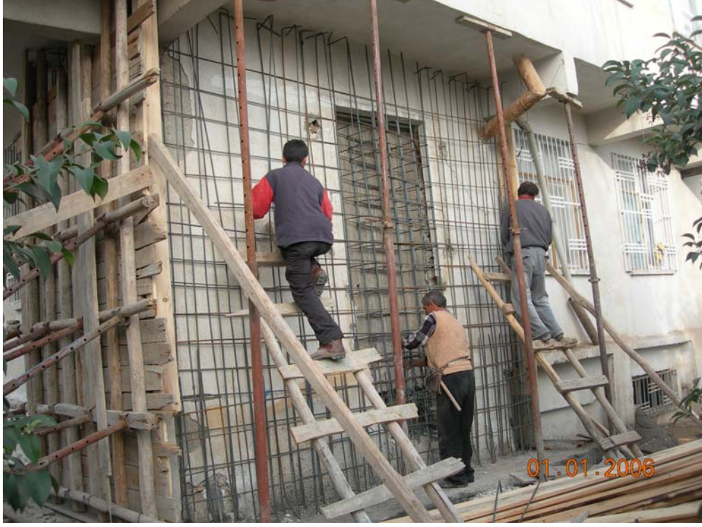
Şekil 4.21. Perde donatısı
