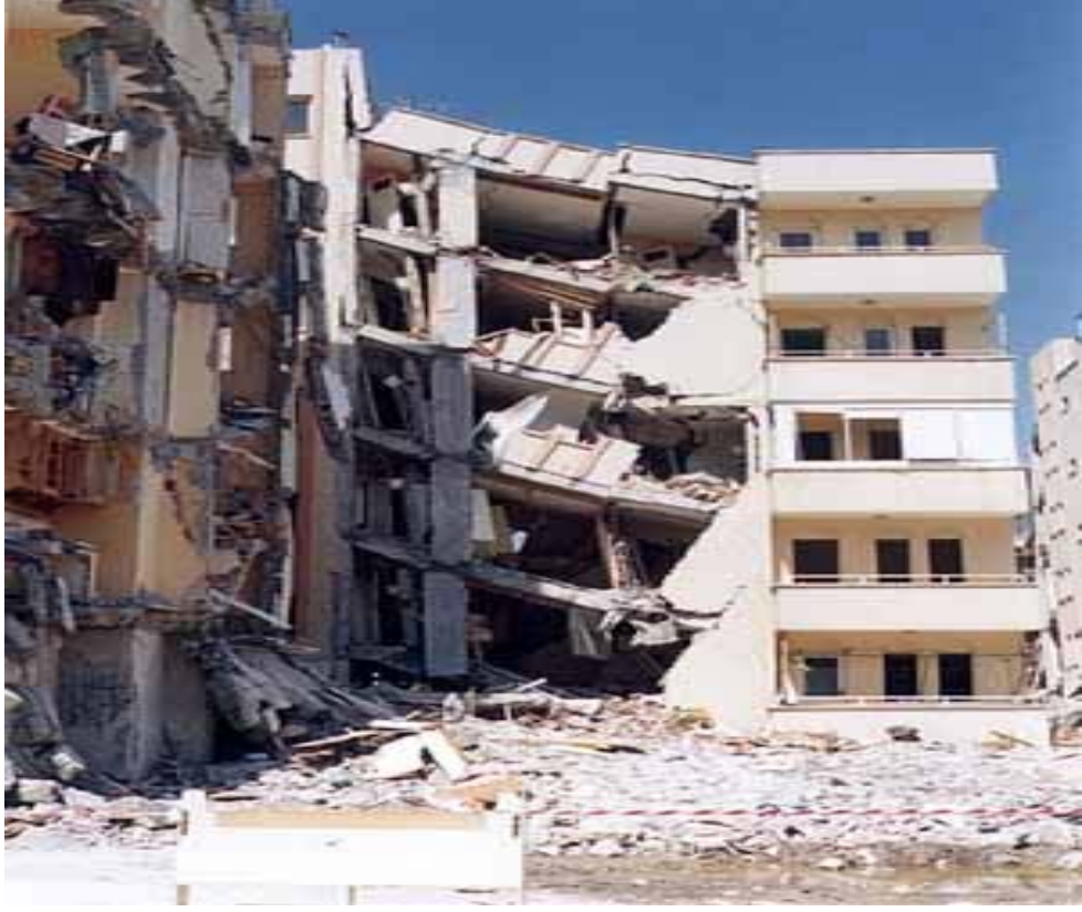
Şekil 1.2. 1998 Adana-Ceyhan depreminde kolonların yapı sistemiyle bütünleştirilememesinden dolayı ağır hasarla yıkılan bina
