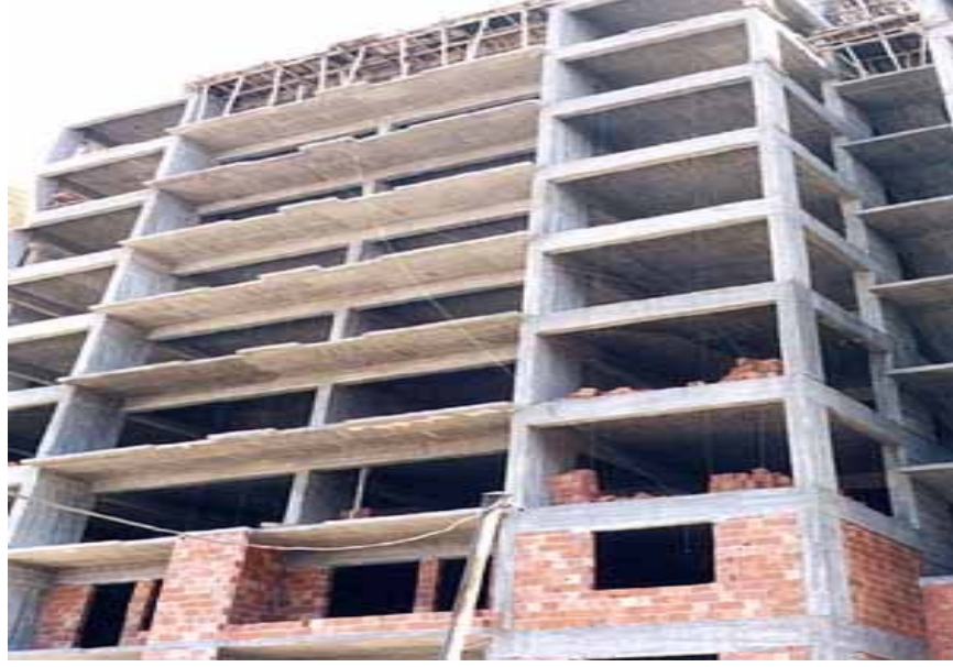
Şekil 1.1. 1998 Adana-Ceyhan depremini hiçbir hasar görmeden atlatan yönetmelik şartlarına uygun bina
