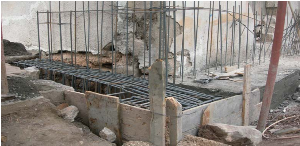
Şekil 4.15. Kalıp bağlanması
