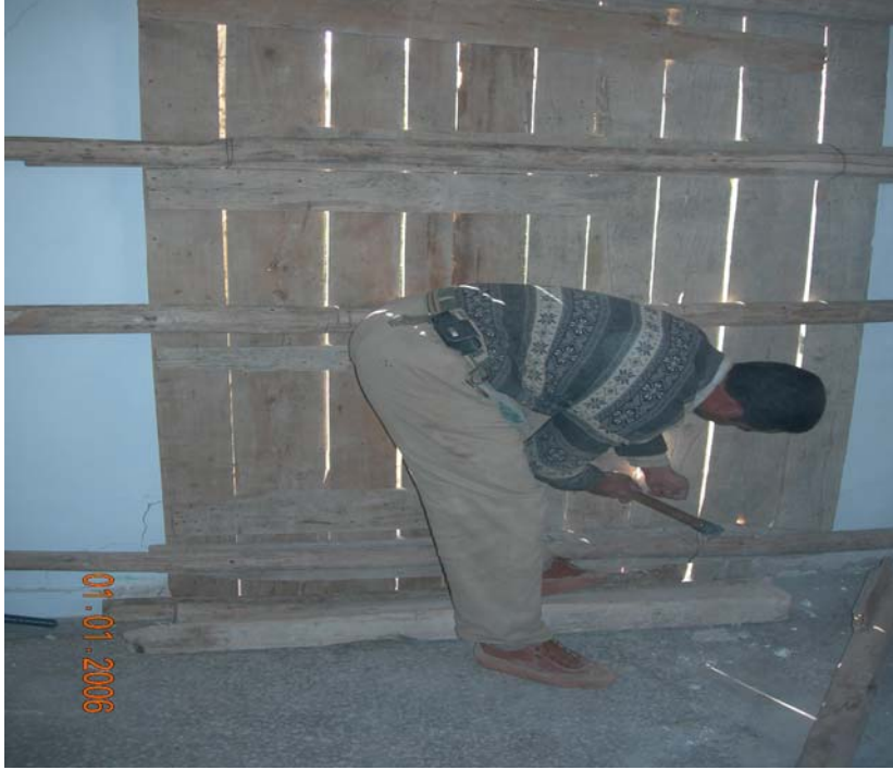
Şekil 4.19. Pencereye kalıp bağlanması
