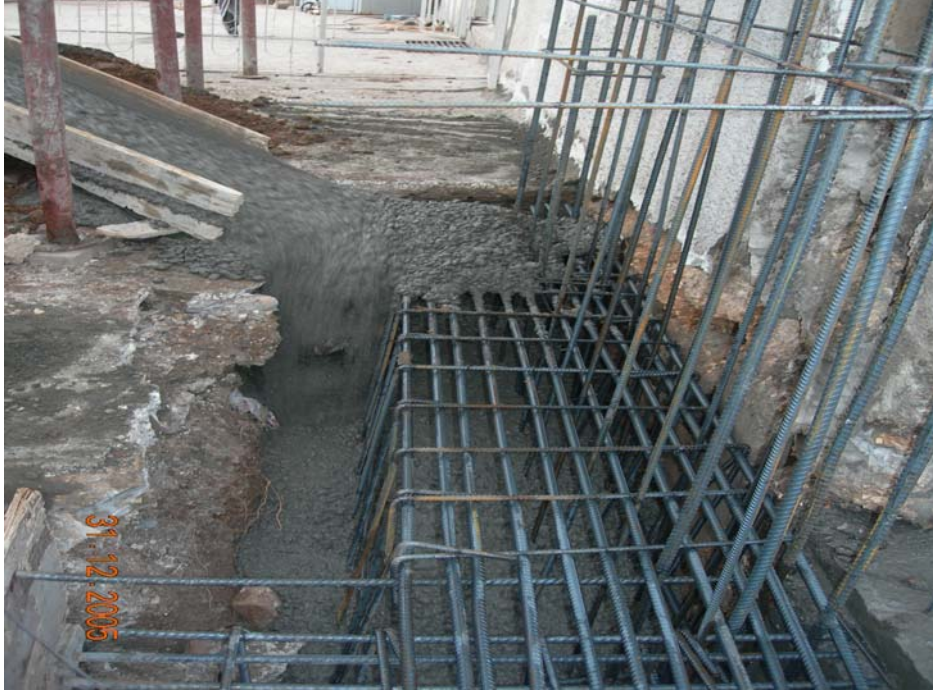
Şekil 4.16. Beton dökümü
