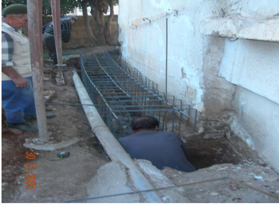
Şekil 4.7. Donatı bağlanması
