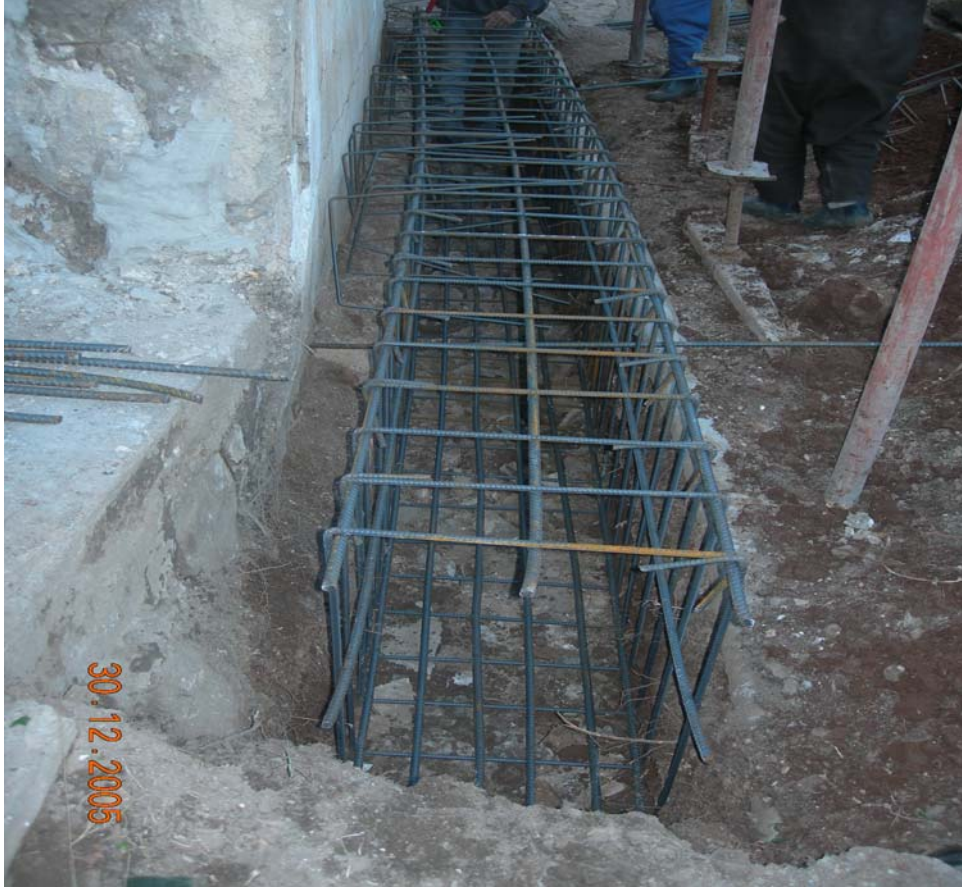
Şekil 4.8. Bağlanan demir donatısı
