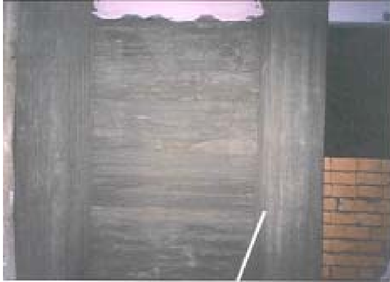
Şekil 2.1. Marmara depremi sonrası Adapazarı'nda bir yapının iki kolonunun perde duvarlarla güçlendirilmesi.
