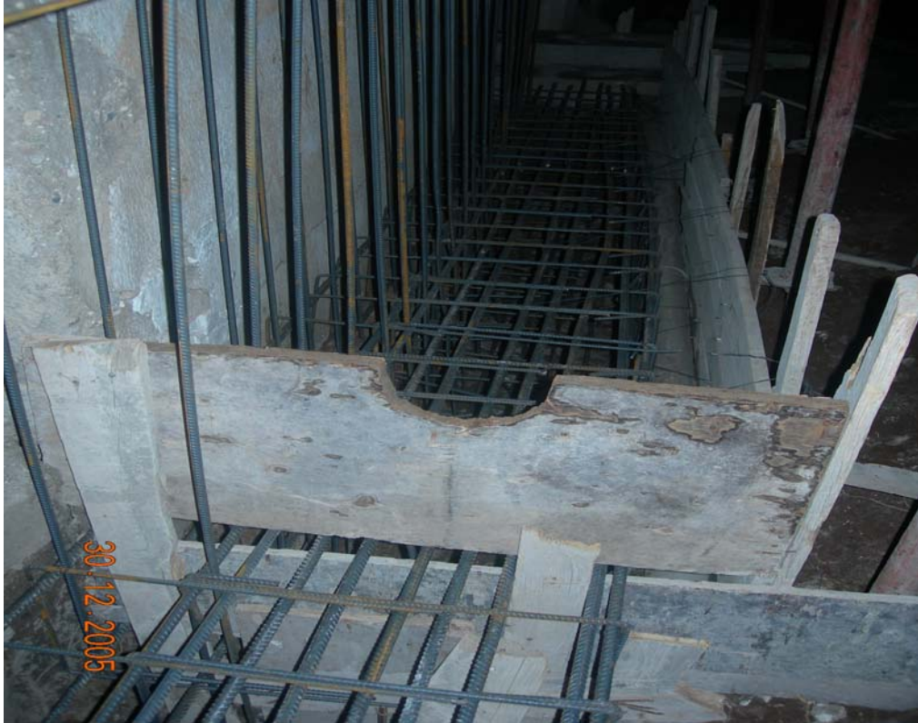
Şekil 4.11. Kalıp bağlanması
