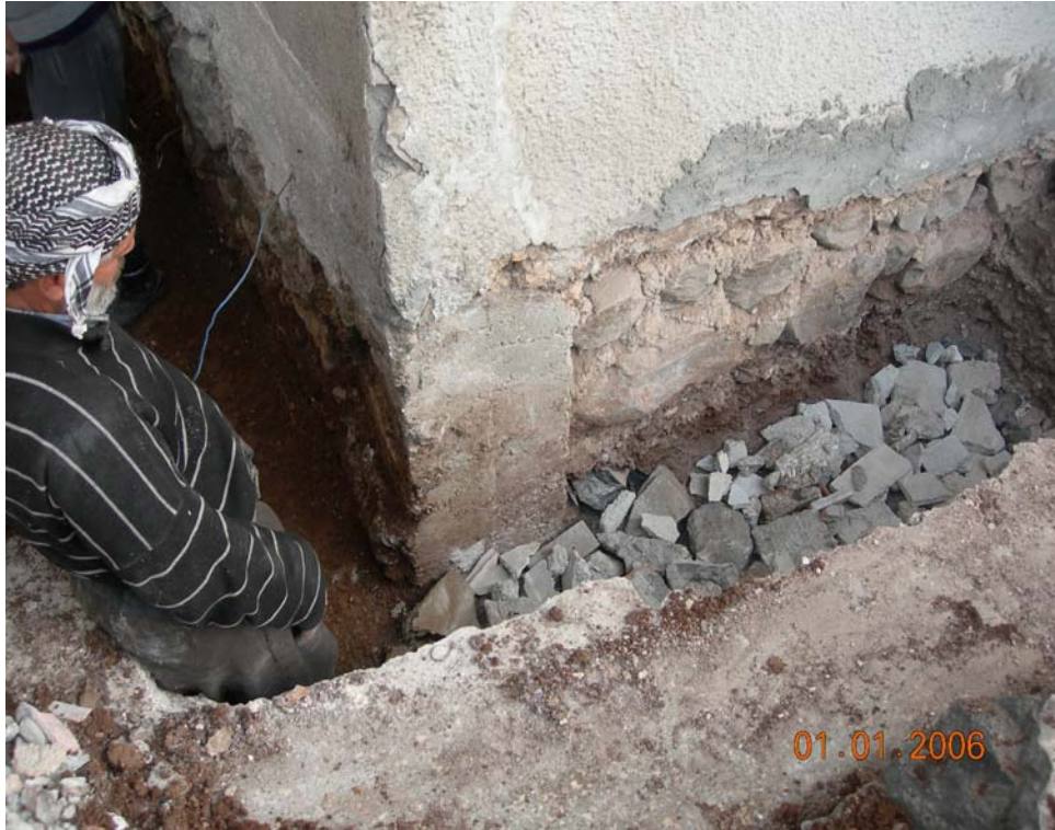
Şekil 4.6. Temel kazısı ve grobeton dökümü
