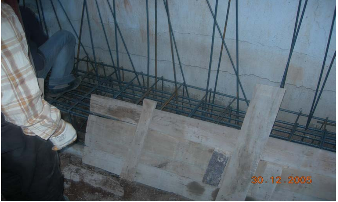
Şekil 4.10. Kalıp bağlanması
