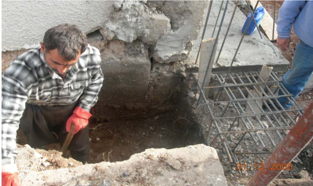
Şekil 4.13. Ön cephe temel kazısı
