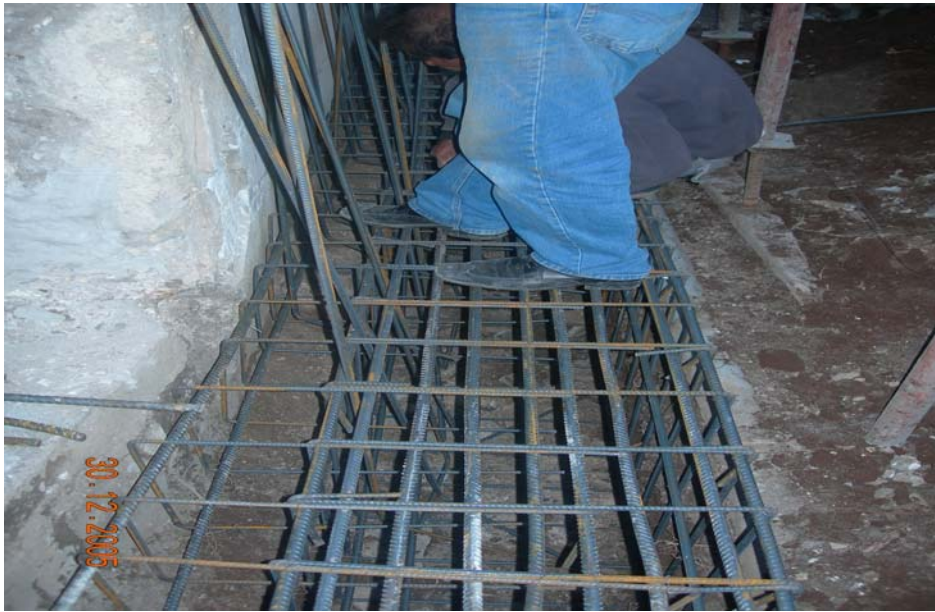
Şekil 4.9. Bağlantı için dışarıda bırakılan donatılar
