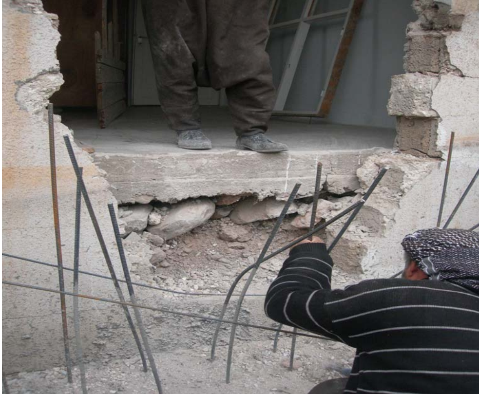
Şekil 4.18. Güçlendirme perdeyle sağlanacak bağlantı için duvar yıkılmıştır.
