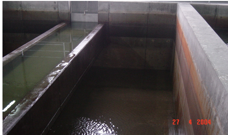
Şekil 2.6. Hızlı kum filtresi
