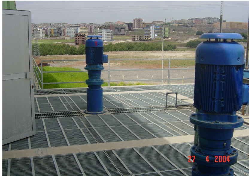
Şekil 2.3. Pıhtılaştırma havuzları ve karıştırıcılar
