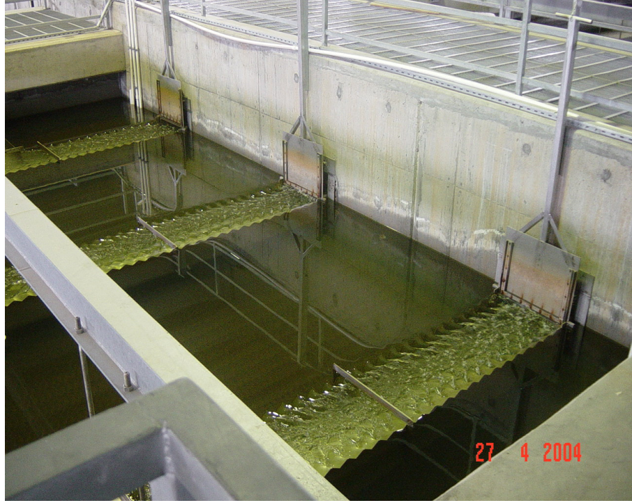
Şekil 2.5. Durultma havuzu ve toplama kanalları
