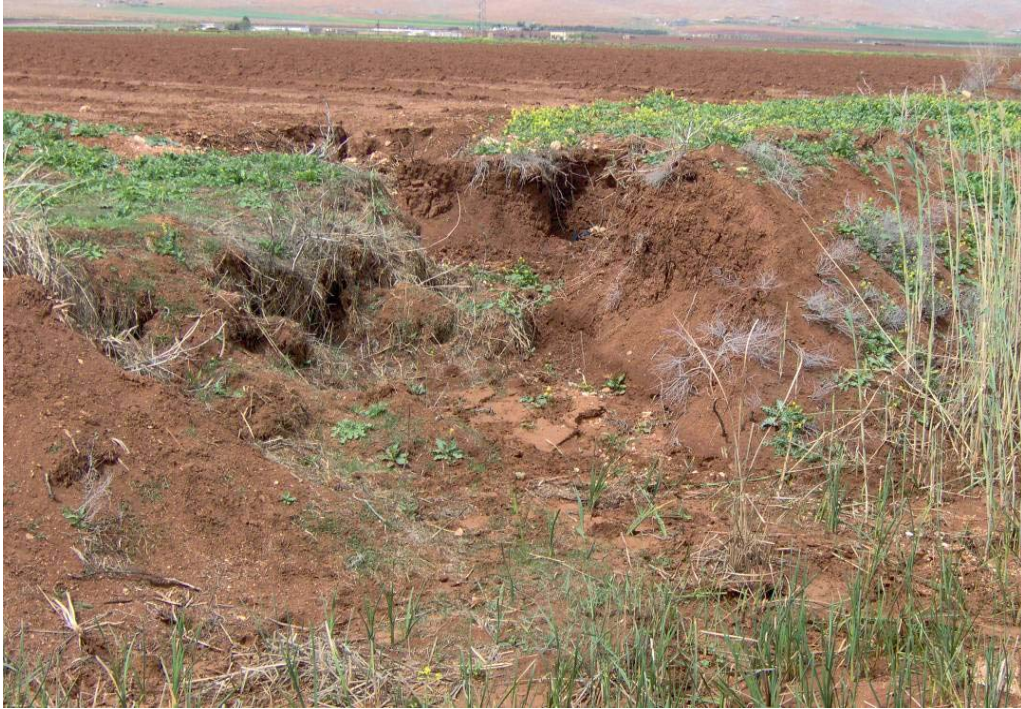
Şekil 4.19. Urfa drenaj kanalı şev akmaları ve bitki oluşumu
