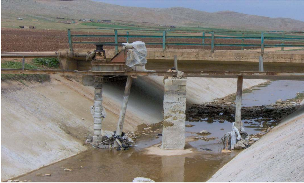
Şekil 4.13. Urfa ana kanalı üzerinde sistem dışı bir su alma yapısı
