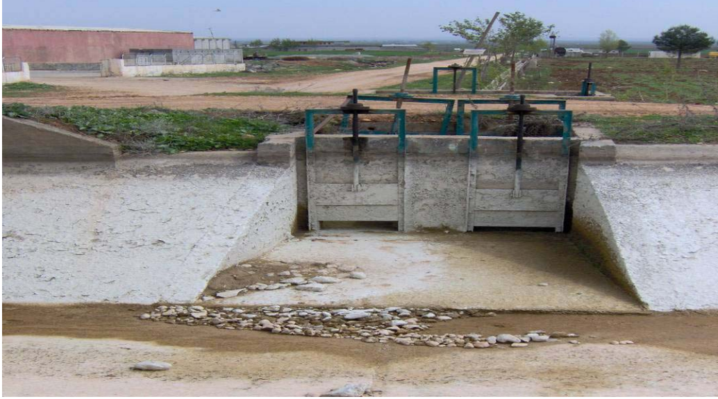
Şekil 4. 8. Sorunlu bir sabit yüklü orifisli priz, Urfa ana kanalı
