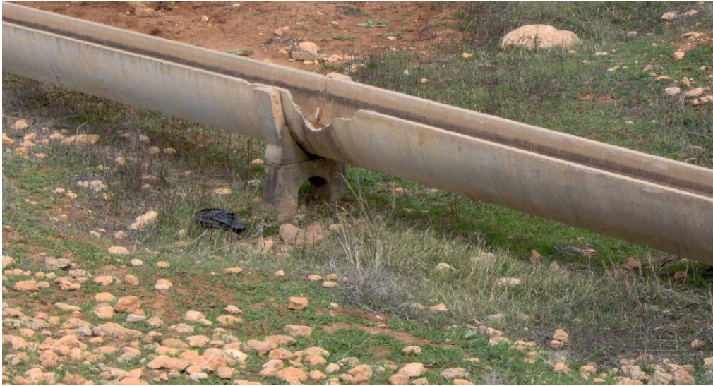
Şekil 4.10. Kanaletlerin kırılarak su alınması
