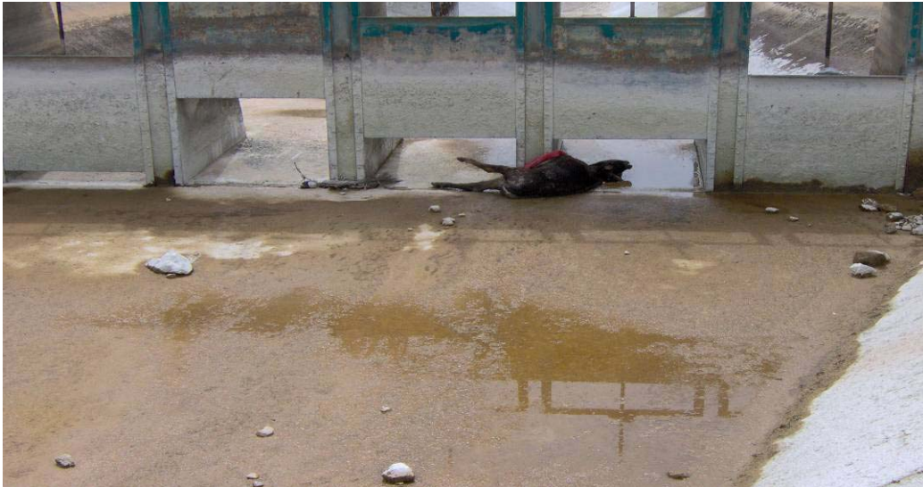
Şekil 4.17. Urfa ana kanalındaki bir su yapısının kapağına sıkışmış bir hayvan
