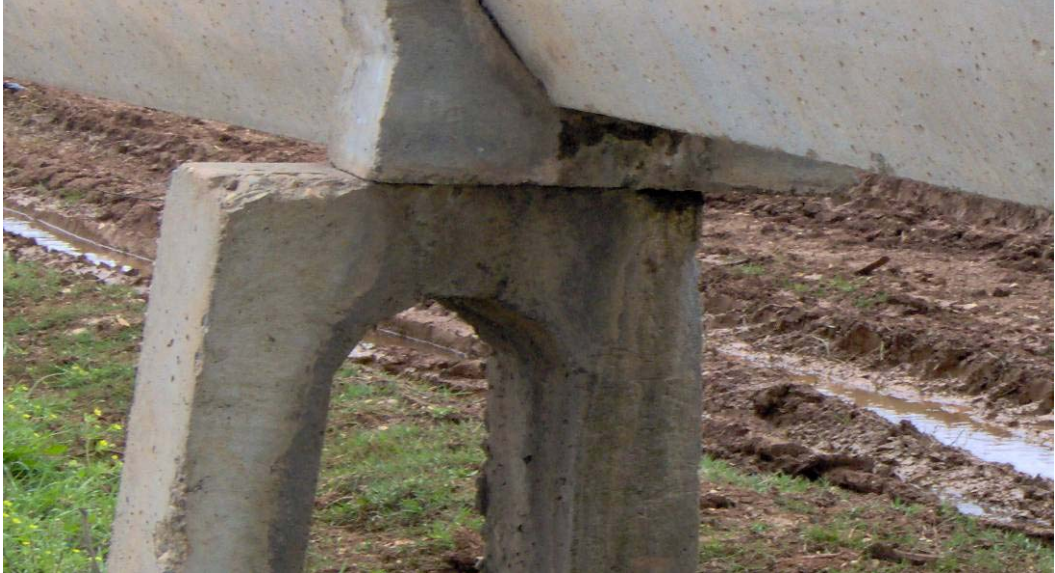
Şekil 4.12. Kanaletlerde sabit ayaklardaki kayma
