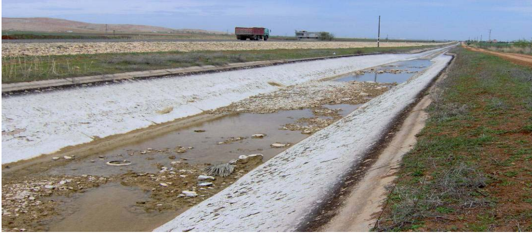
Şekil 4.15. Urfa ana kanalı içerisindeki taşlar ve kumlar
