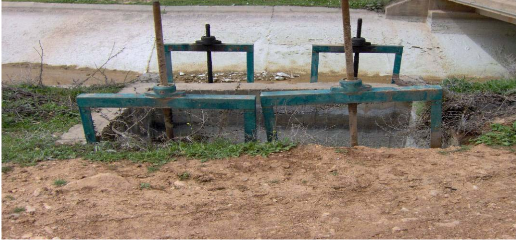
Şekil 4.7. Sorunlu bir sabit yüklü orifisli priz, Urfa ana kanalı
