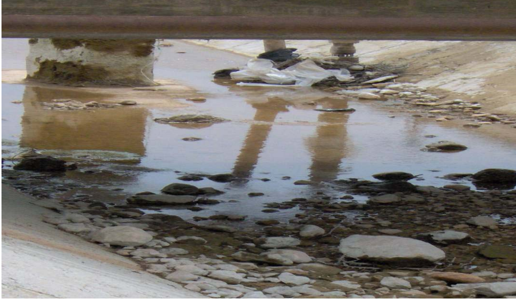
Şekil 4.16. Urfa ana kanalı içerisindeki taşlar ve diğer malzemeler
