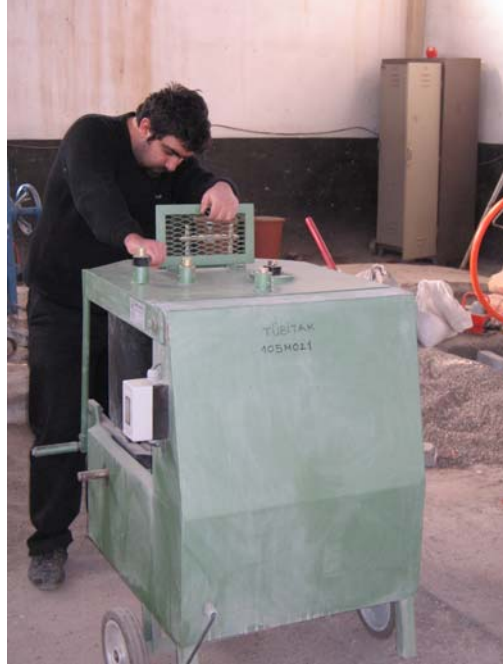
Şekil 3.4. Beton karışımının hazırlanması
