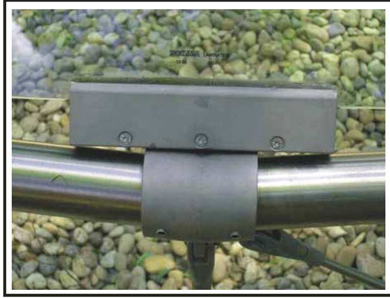
Şekil 2.6. Prof. Werner Sobek ve Doktora öğrencisi Lucio Blandini tarafından Stuttgart Üniversitesi bahçesinde yapılmış cam kubbe yapının taban bağlantısı (Blandini, 2005)
