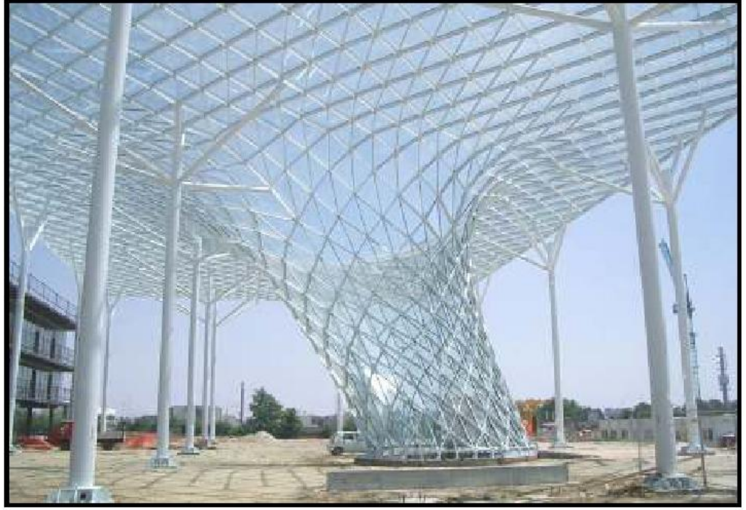
Őekil 3.9. Tek cidarlı konstrüksiyon görünüşü
