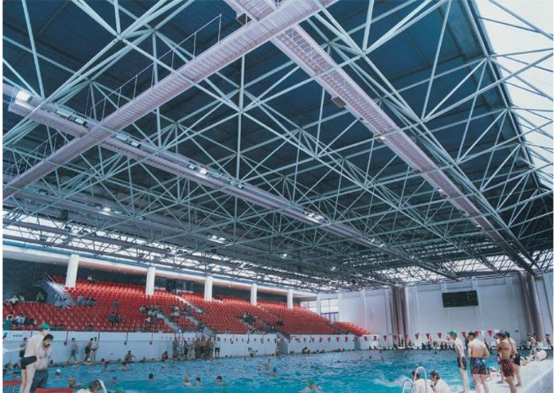
Şekil 3.12. Uzay kafes sistem kapalı yüzme havuz çatısı
