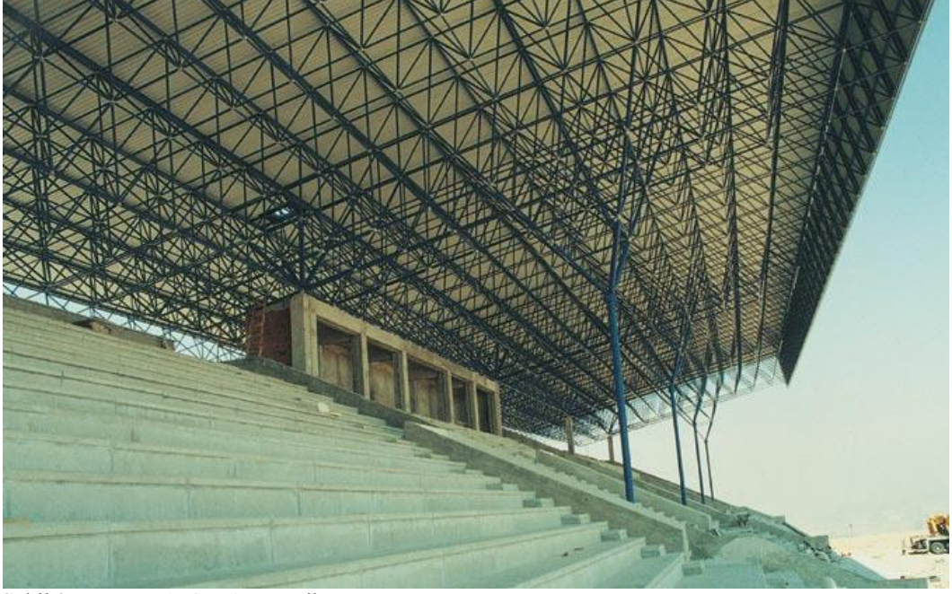
Şekil 3.13. Uzay kafes sistem tribün çatısı
