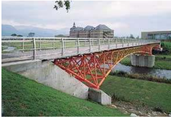
Şekil 3.1. Uzay kafes sistem köprü örneği
