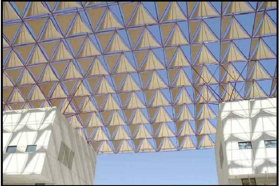
Şekil 3.6. Uzay kafes sistem gölgelendirme çatısı
