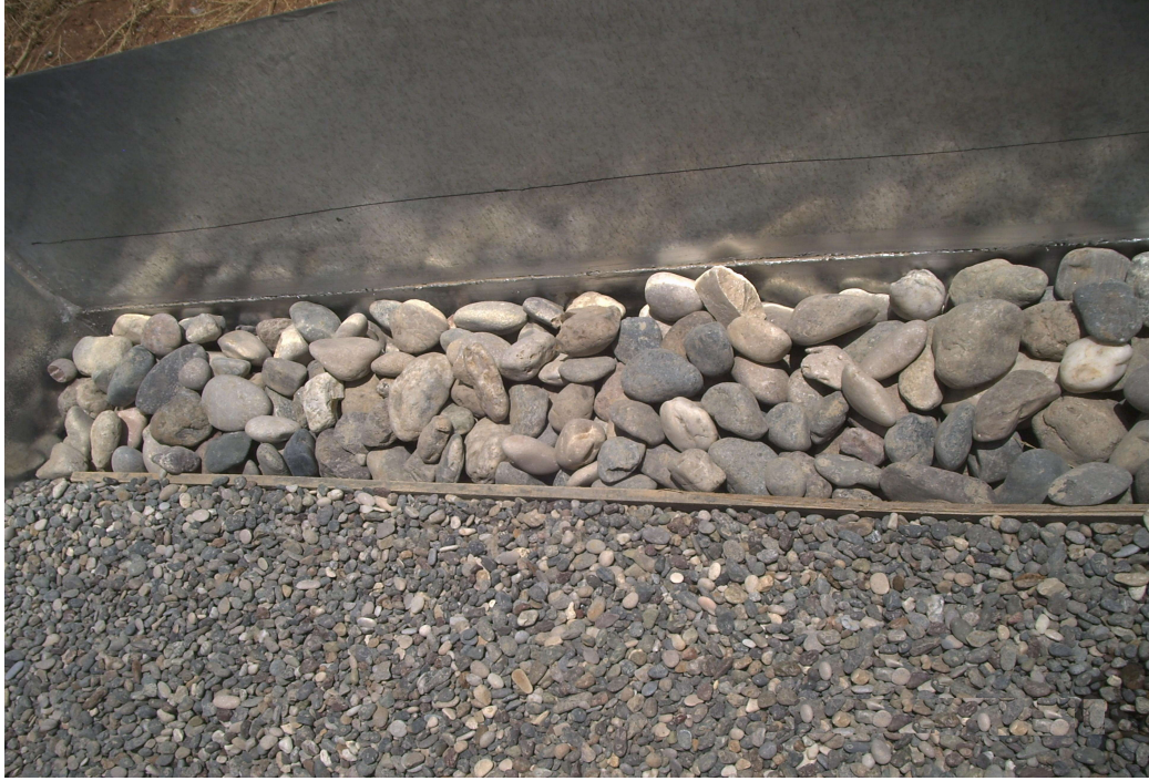
Şekil 3.6. Sistem dolgu malzemesi olarak yıkanmış nehir çakılı
