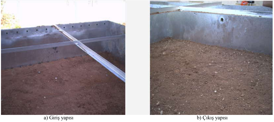
Şekil 3.7. Serbest yüzey akışlı sistem giriş ve çıkış yapıları
