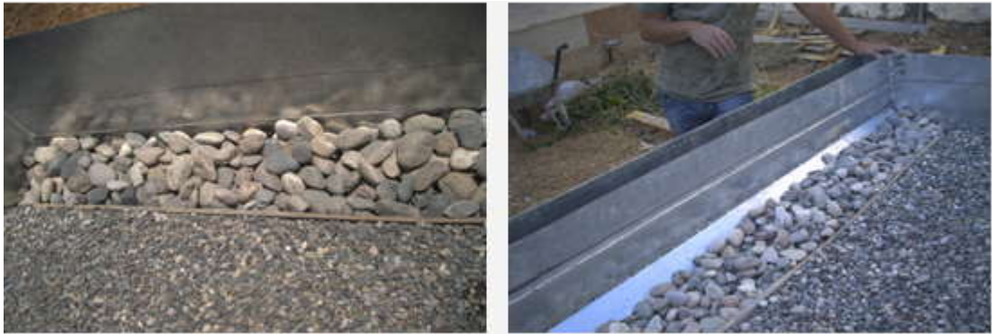
a) Giriş dolgu malzemesi dizaynı
