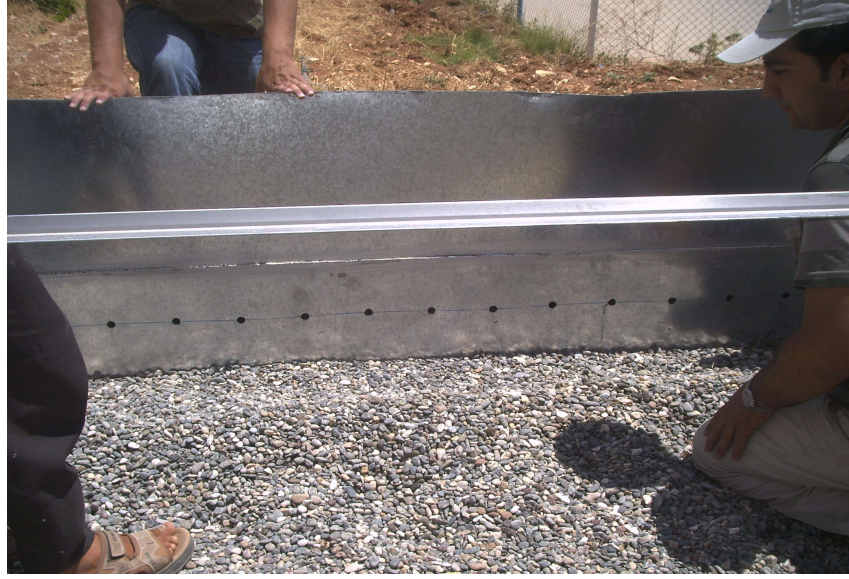
Şekil 3.8. Yüzeyaltı akışlı sistem giriş yapısı
