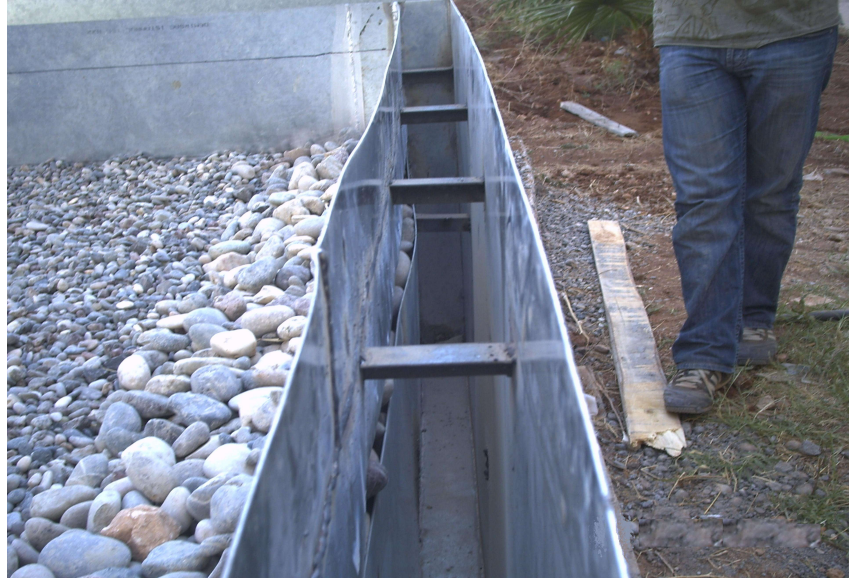
Şekil 3.9. Yüzeyaltı akışlı sistem çıkış yapısı
