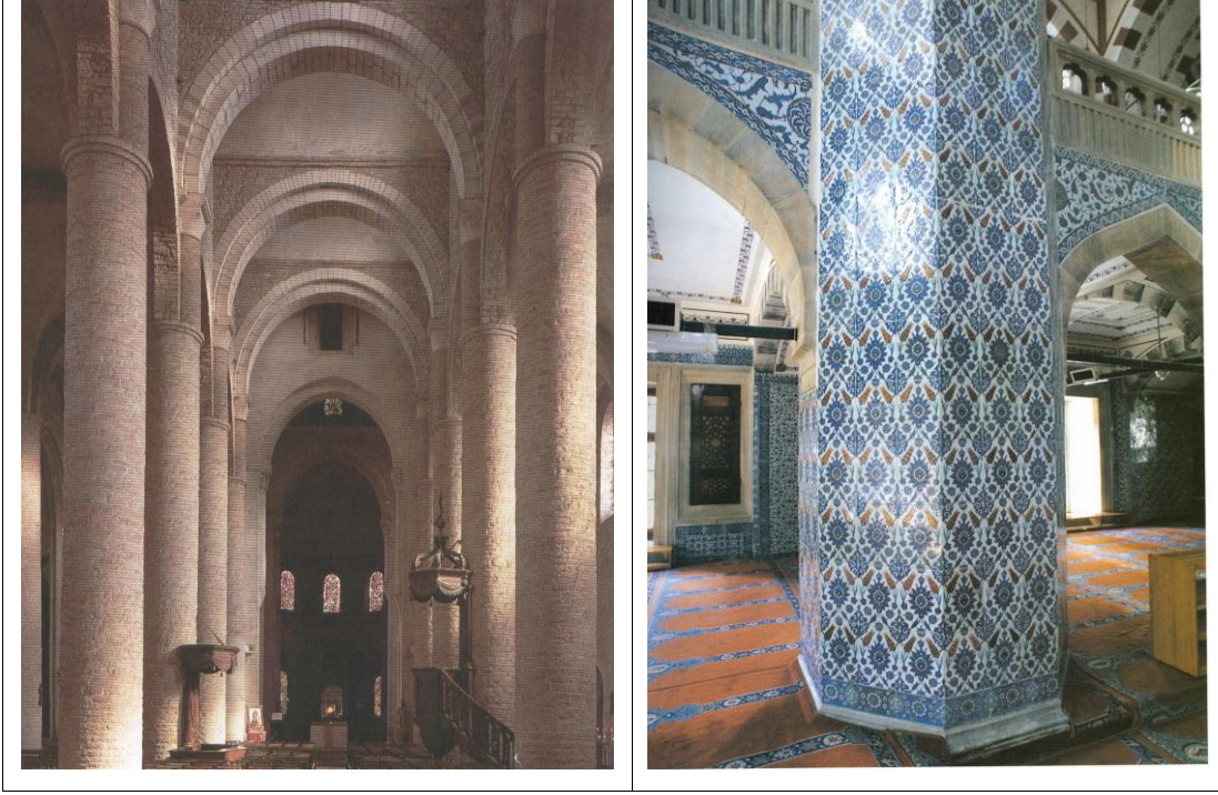
Şekil 1.2. Saint-Philibert Kilisesinin dairesel tuğla kolonları (sol resim) (Toman, 1997) ve Rüstem Paşa Camisinin çini kaplı bir sekizgen kolonu (sağ resim) (Aslanapa, 2004)
