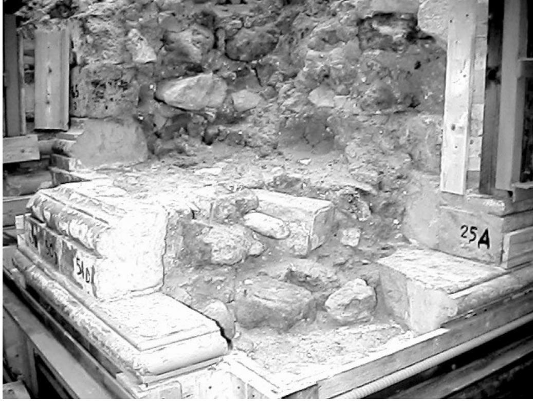
Şekil 4.7. İtalyadaki Noto Katedralinin kolonlarından birinin kesit yapısı (Binda ve ark., 2003)
