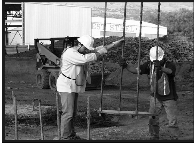
Şekil 3.24. Geopier donatılı çekme kolon uygulaması
