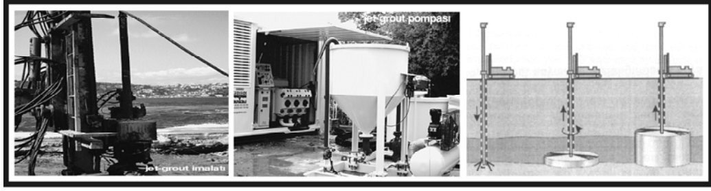
Şekil 3.18. Jet-grouting ekipmanları ve uygulamaları
