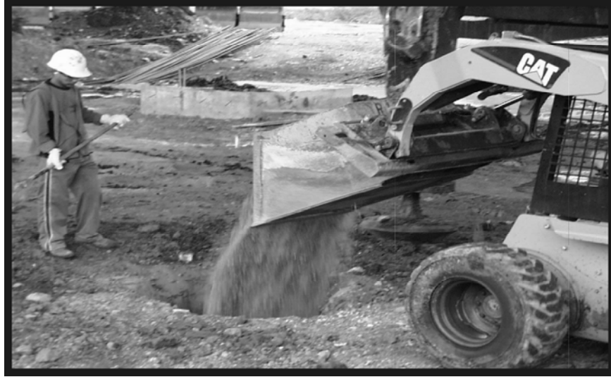
Şekil 3.22. Geopier uygulama şekli
