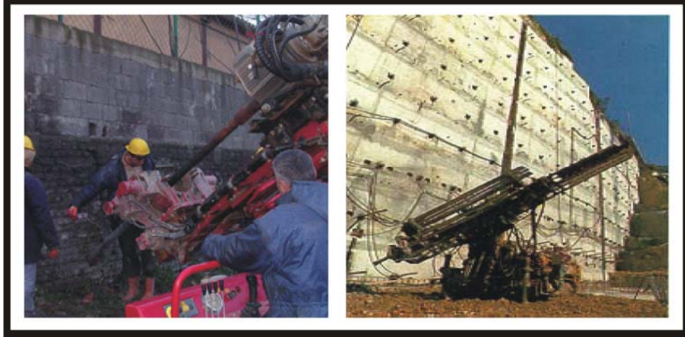
Şekil 3.8. Zemin çivisi uygulamasından 2 görünüm
