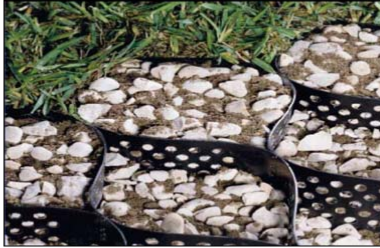
Şekil 3.25. Tipik bir Geocell hücre sistemi
