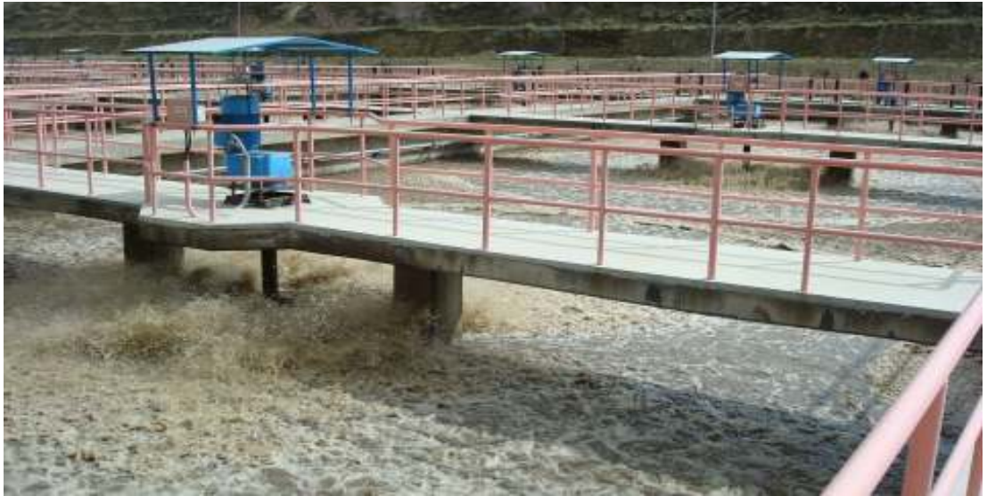
Şekil 1.15. Denizli Merkez Atıksu Arıtma Tesisine ait havalandırma havuzu
