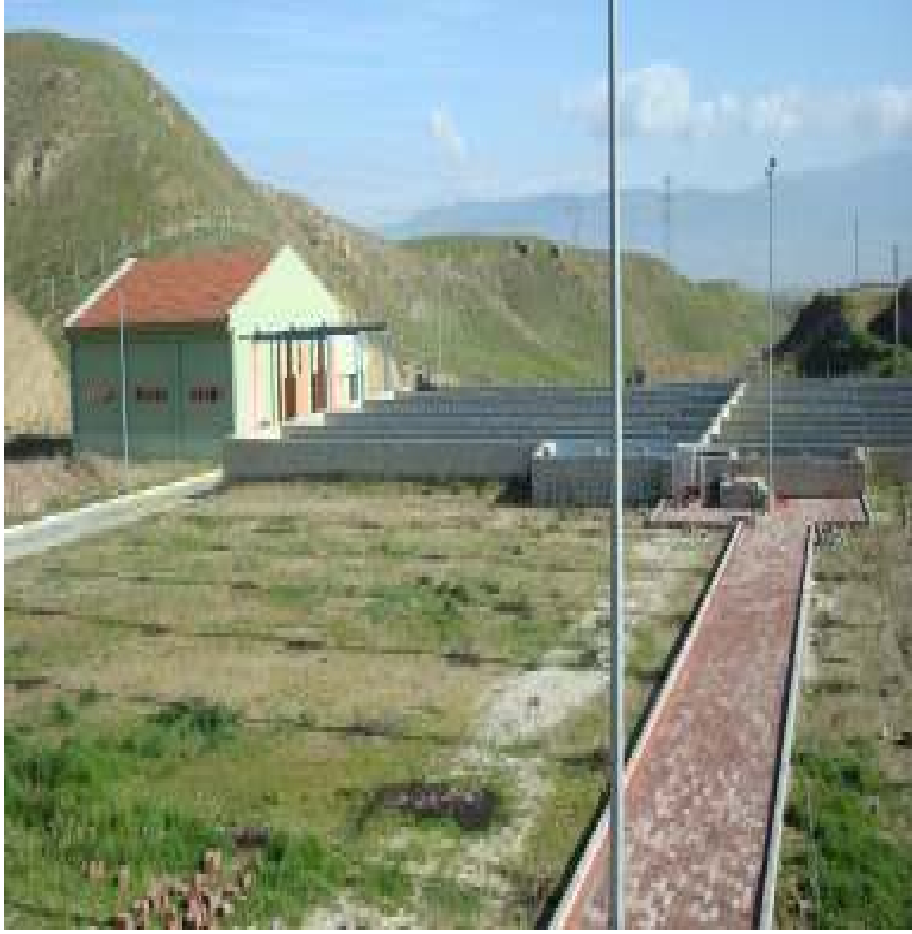
Şekil 1.16. Denizli Merkez Atıksu Arıtma Tesisine ait klorlama havuzu
