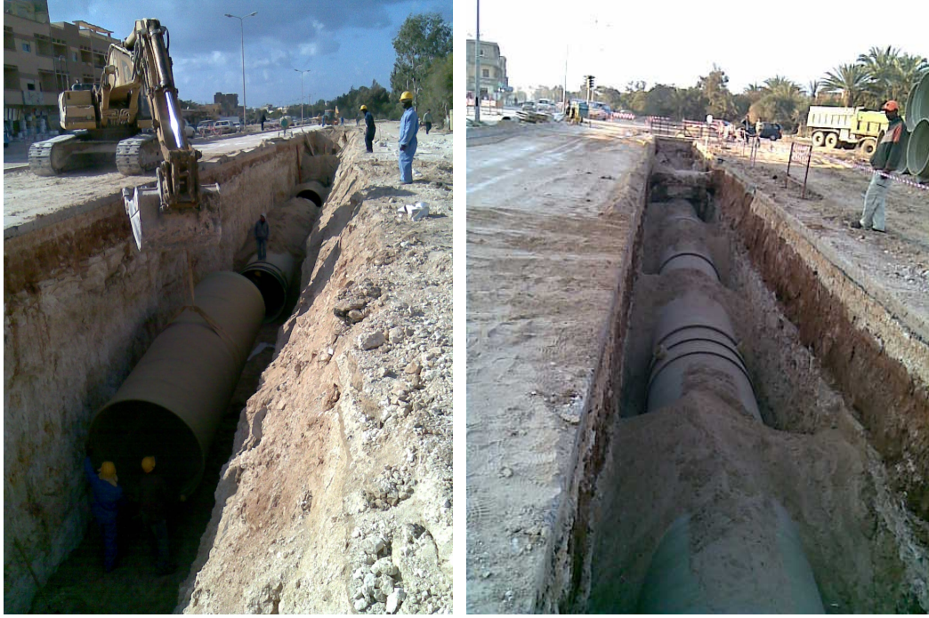
Şekil 3.8 Kanalizasyonda CTP boru kullanımına ait uygulamalar
