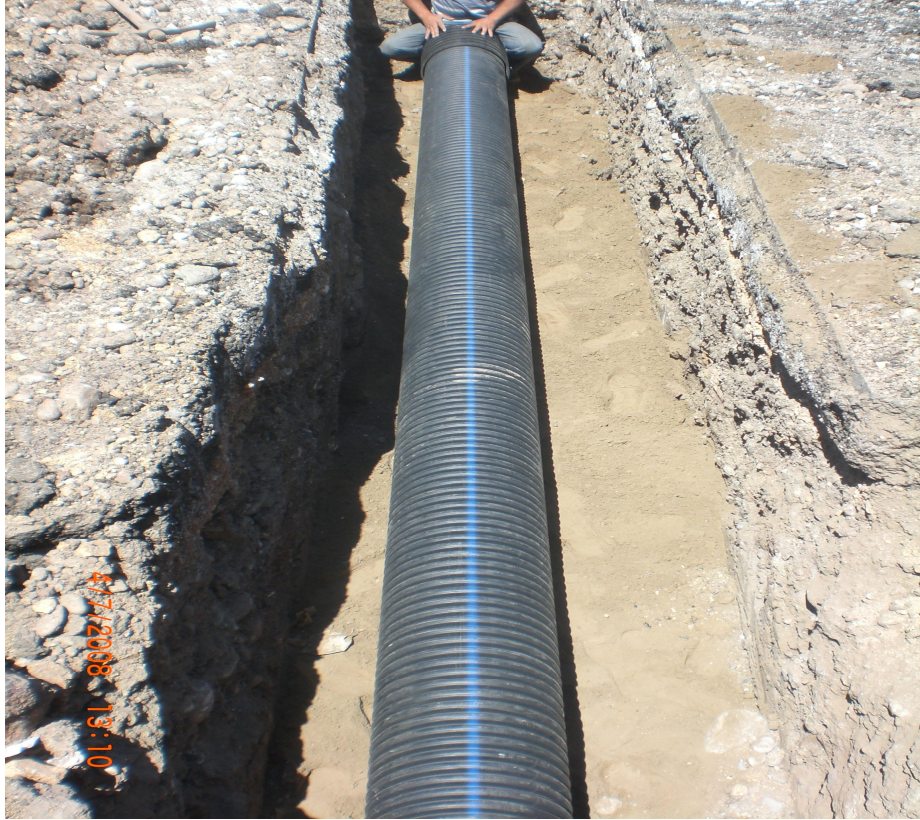
Şekil 3.6. Kanalizasyonda koruge boru kullanımına ait uygulamalar
