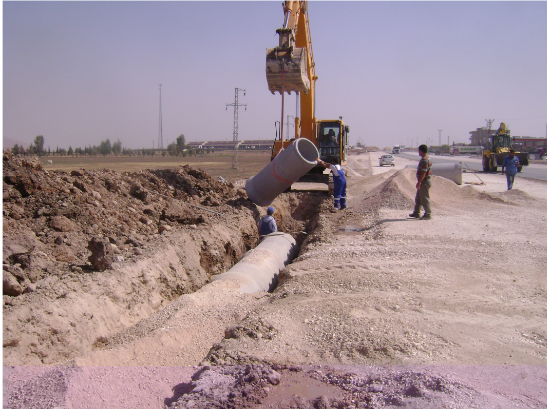
Şekil 3.4. Kanalizasyonda betonarme boru kullanımına ait uygulamalar
