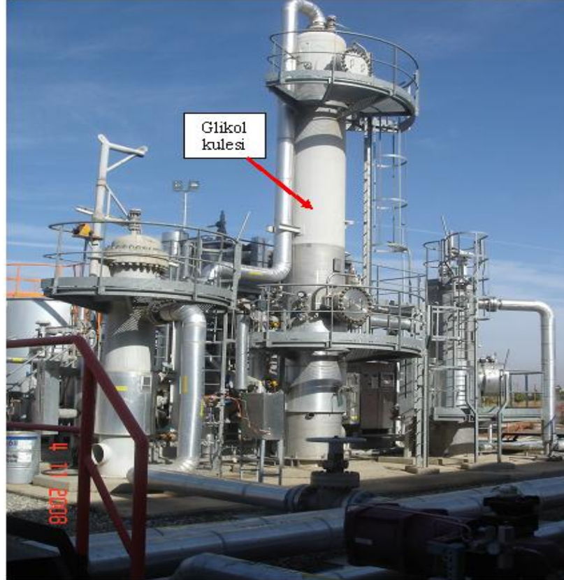
Şekil 3.4. AP2 istasyonu glikol sistemi
