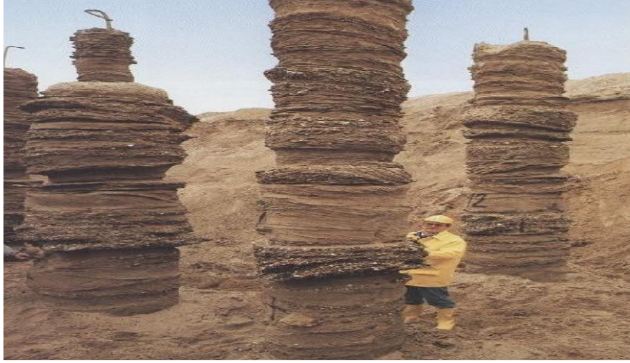
Şekil 3.10. Standart yöntemle oluşturulmuş kolonlar (Osmanoğlu, 2007)
