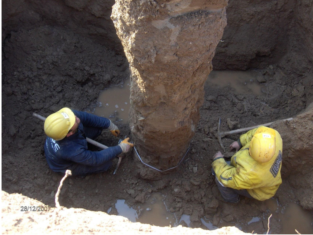
Şekil 3.24. Jet grout kolonlarında çap kontrolü (Yıldız, 2011)
