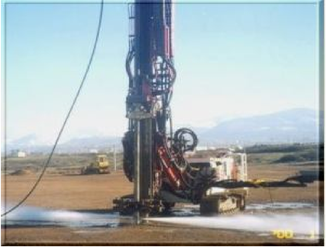
Şekil 3.5. Enjeksiyon aşaması (Bakım, 2007)
