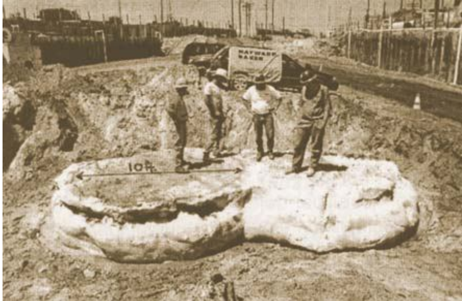
Şekil 3.11. Süper jet yöntemiyle oluşturulmuş kolonlar (Osmanoğlu, 2007)
