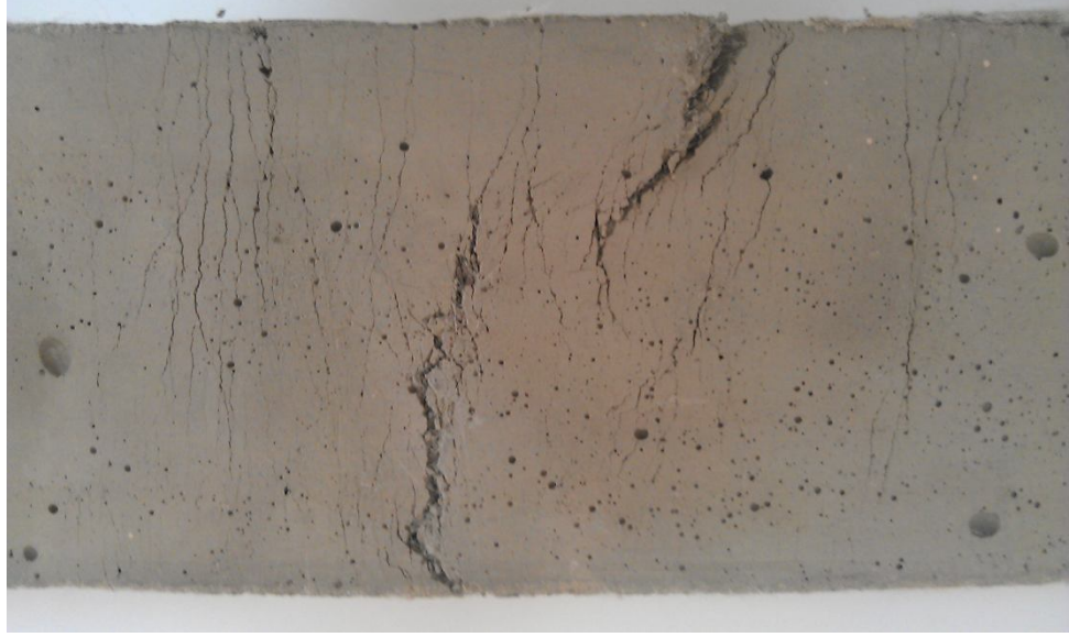
Şekil 4. 12. Çekme yüzünde düzgün yayılı çatlak oluşmuş ECC numunesi
