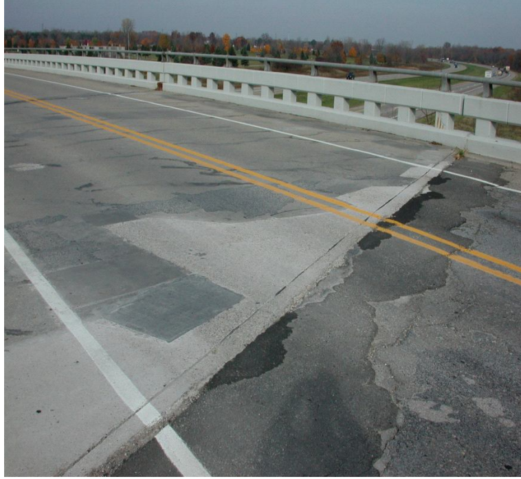
Şekil 2. 14. Michigan’da bulunan köprü tabliyesinde ECC yama tadilatı uygulaması ( Li ve Lepech, 2004)
