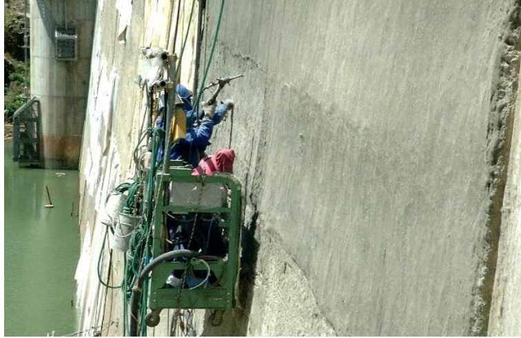
Şekil 2. 12. Mitaka Barajında su yalıtımı tadilatı amacıyla ECC malzemesinin uygulanması (Sakata ve ark., 2004)
