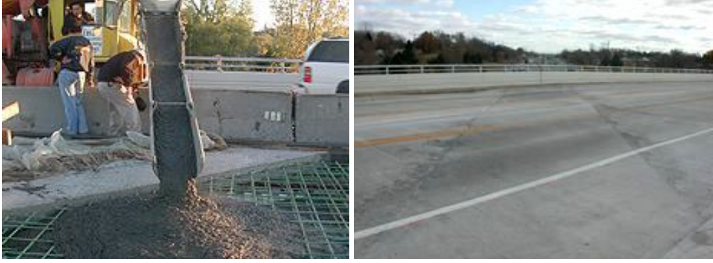
a) Yapım esnası
