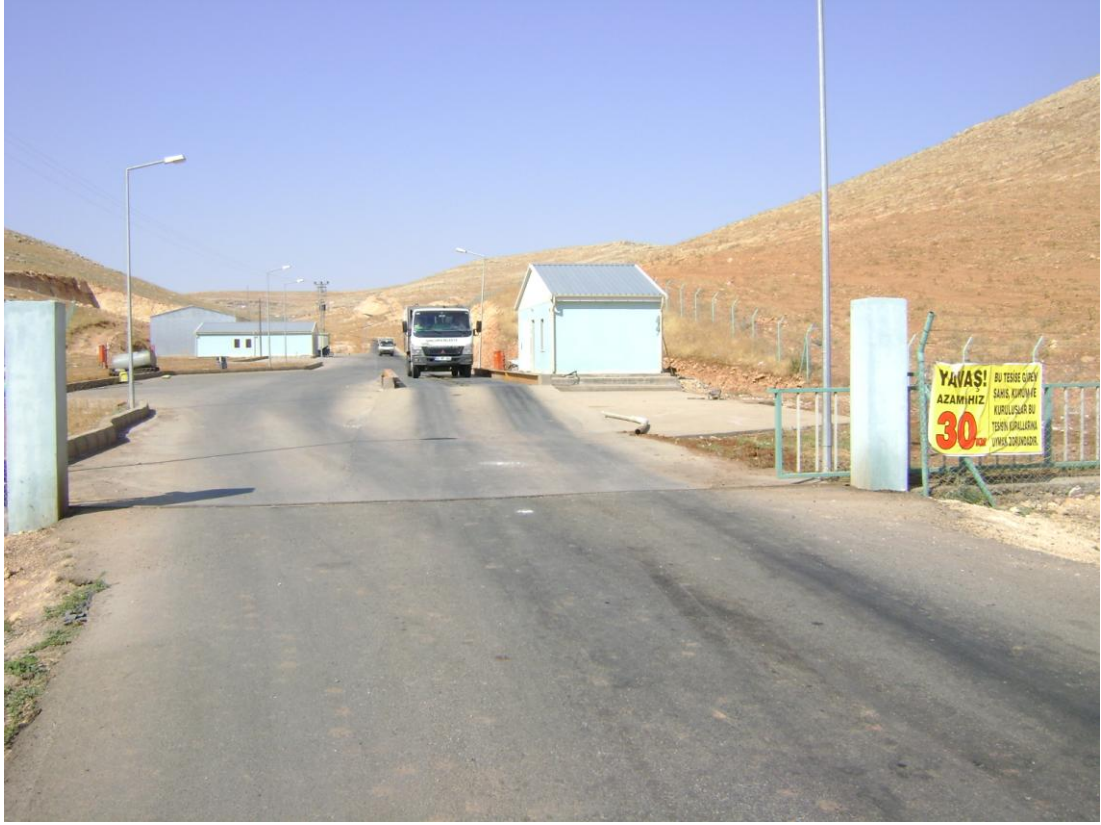
Şekil. 4.6. Düzenli depolama sahasının girişi
