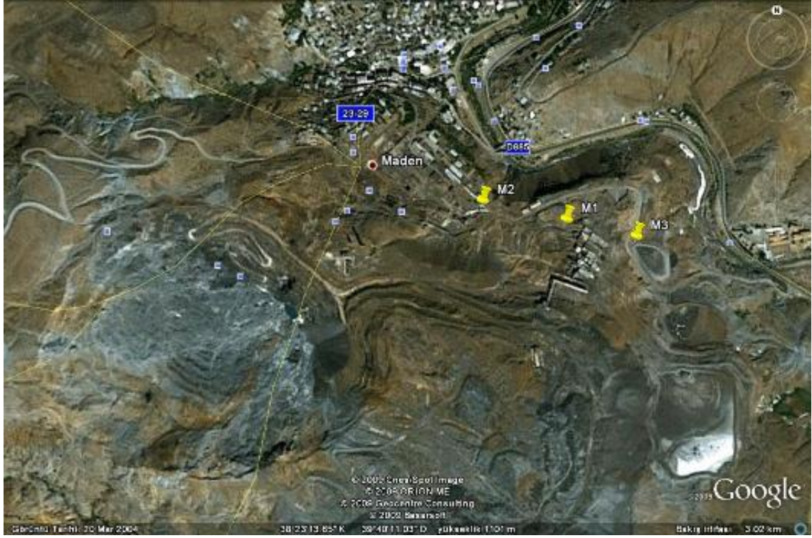
Şekil 3.4. Genel görünüm ve 1 nolu örnekleme noktası(M1), drenaj kanalı(M2) ve drenaj havuzu(M3) yerlerini gösteren uydu görüntüsü
