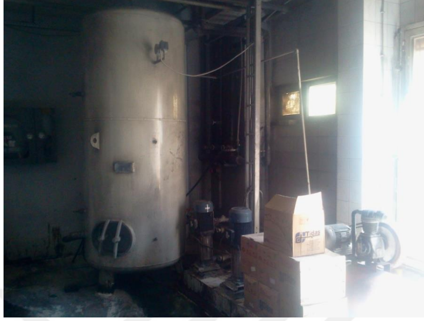
Şekil 4.6. Su Pompasına ait görüntü
