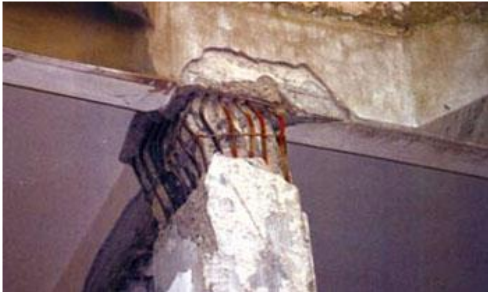
Şekil 3.13. Etriye sıklaştırması yetersizliği
