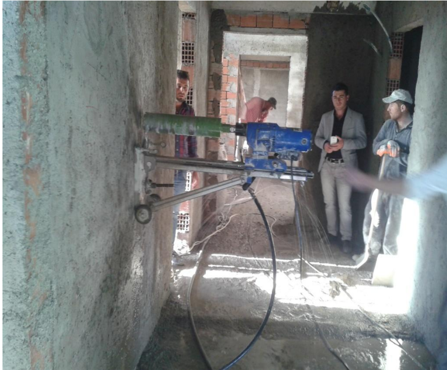
Şekil 3.2. Karot alma yöntemi
