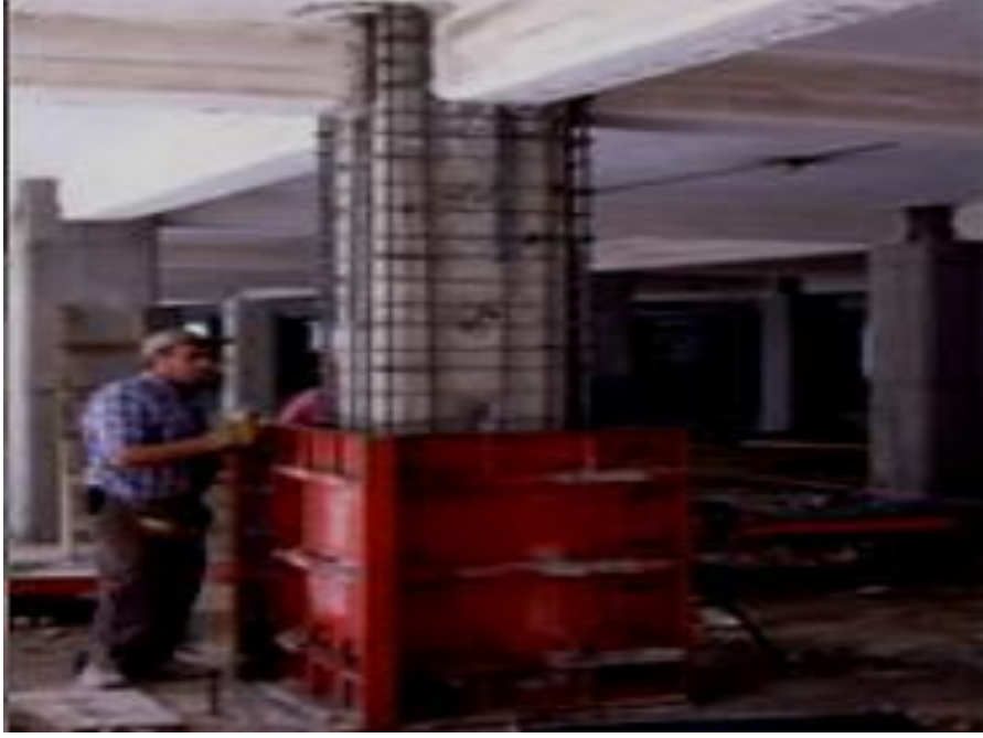
Şekil 3.21. Kolonu mantolayarak güçlendirme
