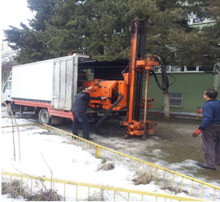
Şekil 3.4. Zemin etüdü için sondaj yapma
