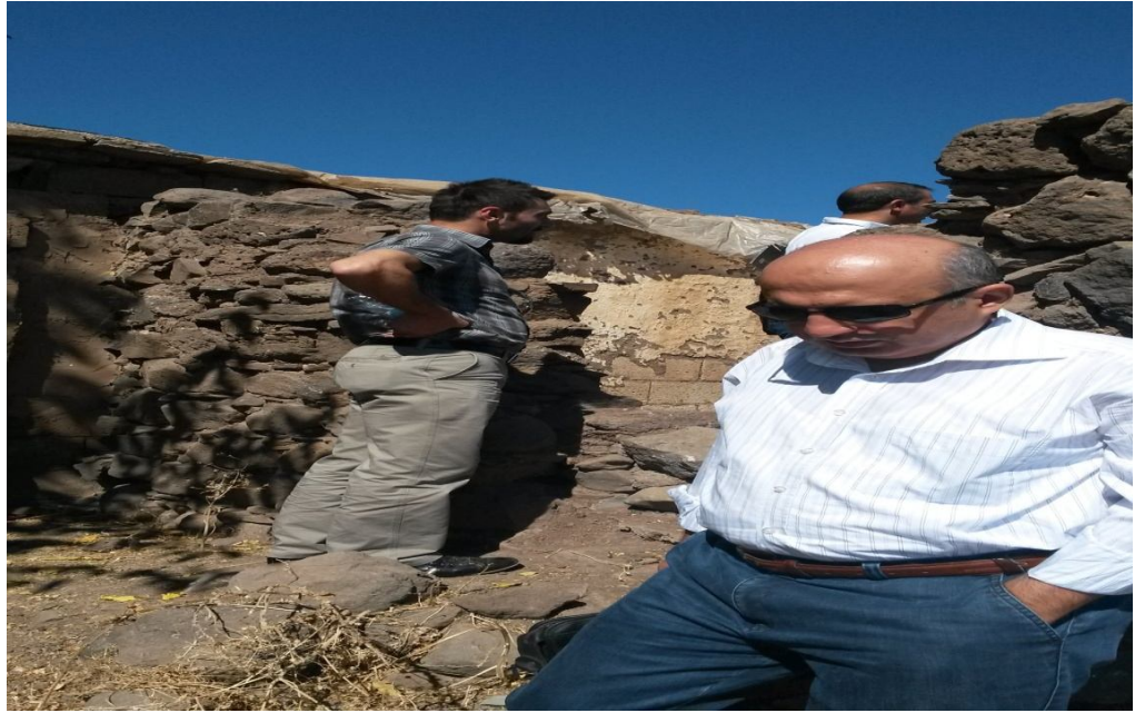
Şekil 4.5. Başyamaç Köyü asbest taraması (2013).
