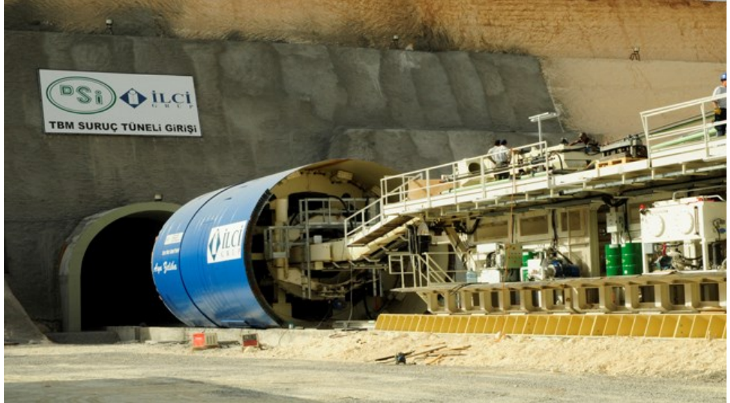
Şekil 1.1 Şanlıurfa Suruç tüneli ve tünel delme makinesi (TBM)
